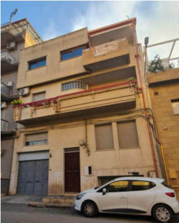
Esterno del fabbricato in cui ricadono gli immobili
