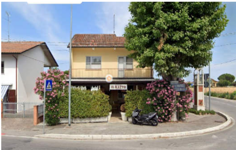
Prospetto su via Canale di Bonificazione
