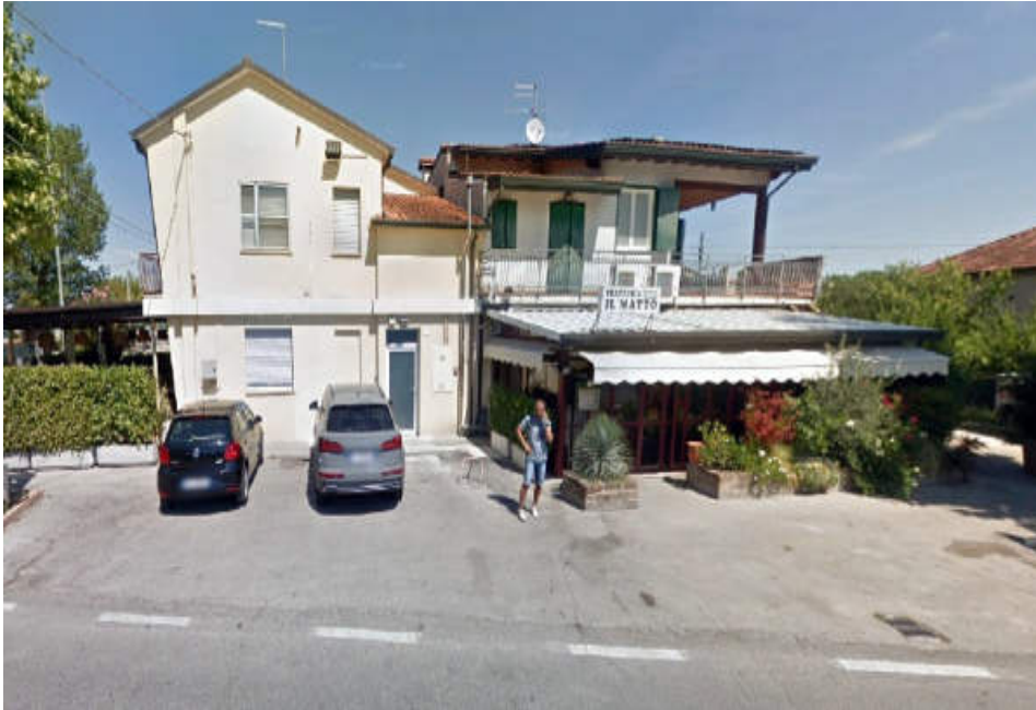
Prospetto su via Fenili
