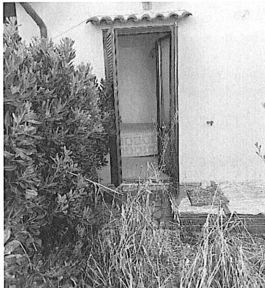
Figura 6 – Vista accesso dalla camera nella corte sul retro
