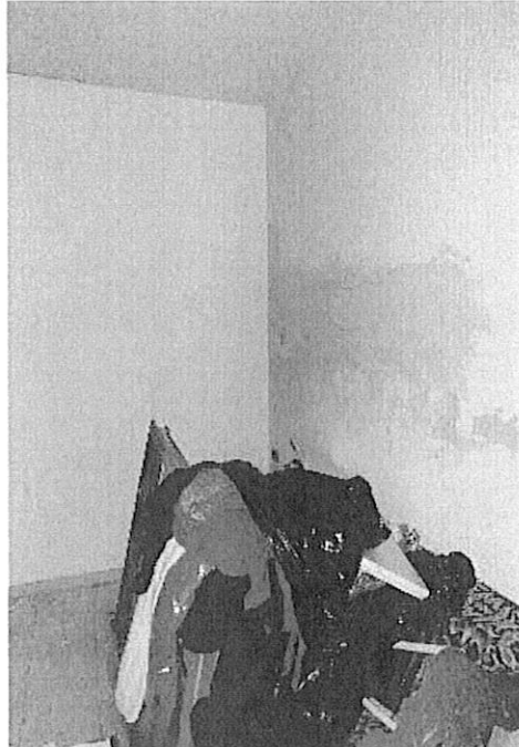
Figura 17 - Vista porzione locale cantina piano interrato
