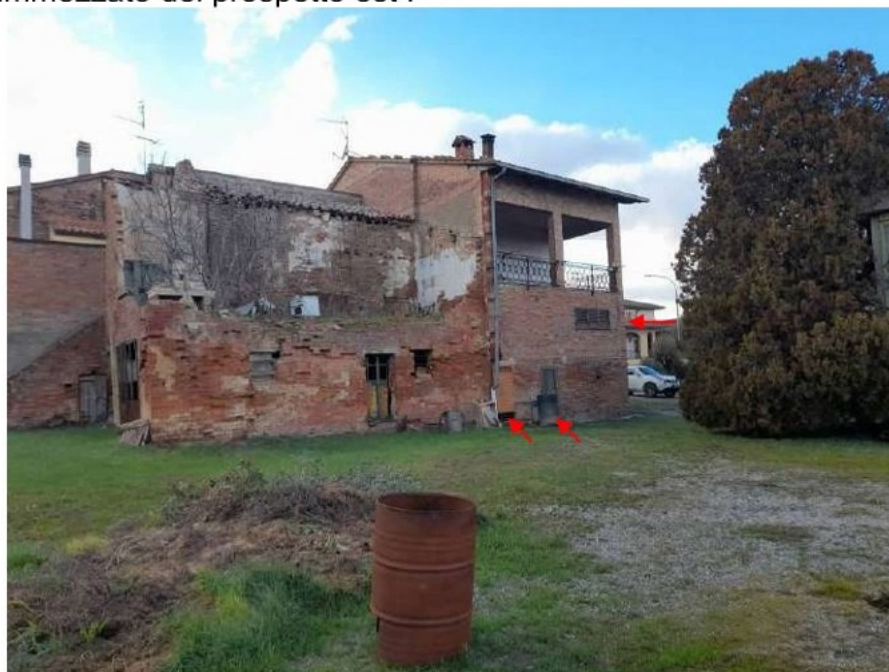
Stato attuale lato est
