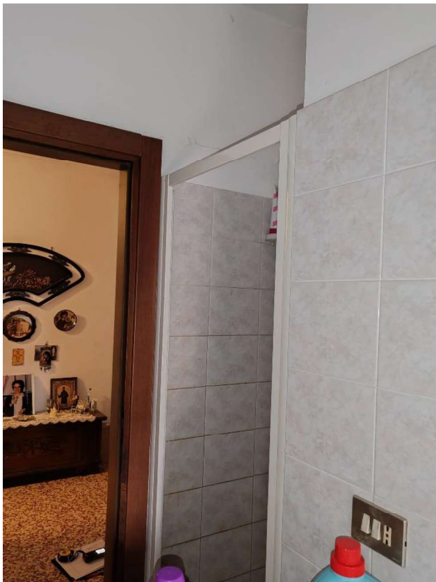
Ripresa fotografica n. 25 Particolare bagno di servizio P7
