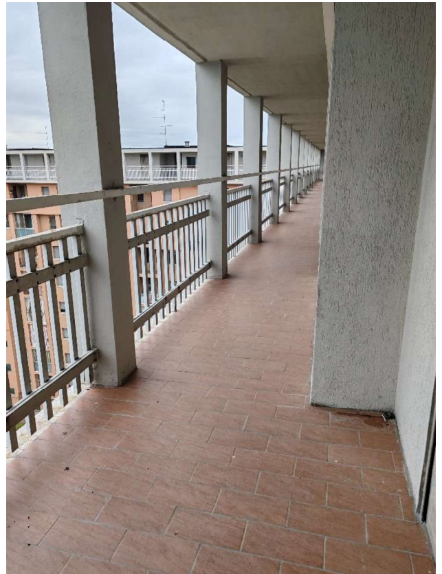
Ripresa fotografica n. 46 Particolare balcone di accesso alla soffitta P9
