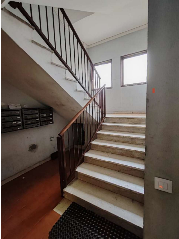
Ripresa fotografica n. 05 Particolare vano scala PT
