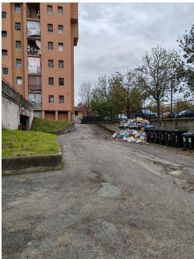
Ripresa fotografica n. 49 Particolare rampa di accesso al piano interrato
