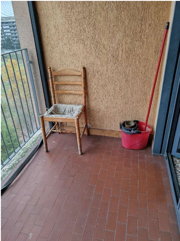
Ripresa fotografica n. 45 Particolare balcone soggiorno P7
