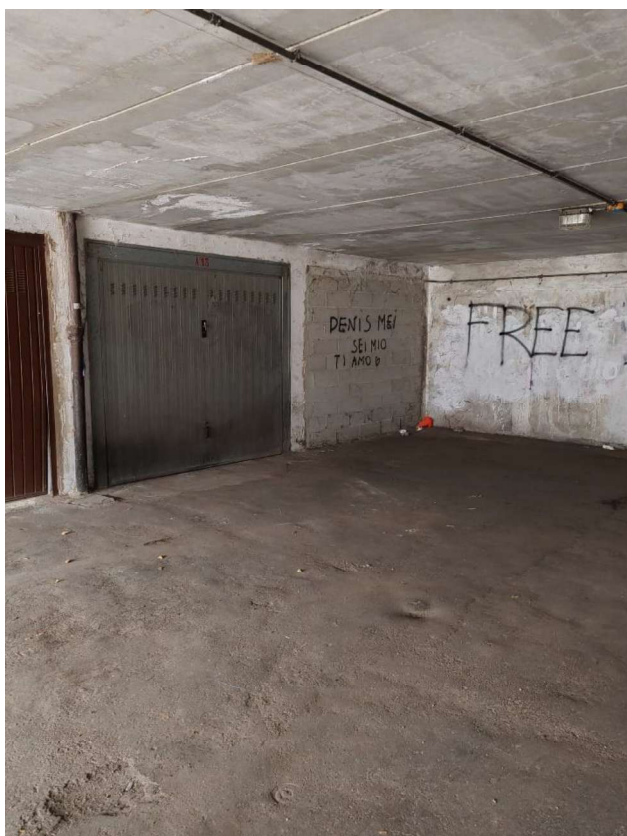
Ripresa fotografica n. 51 Particolare accesso garage PI
