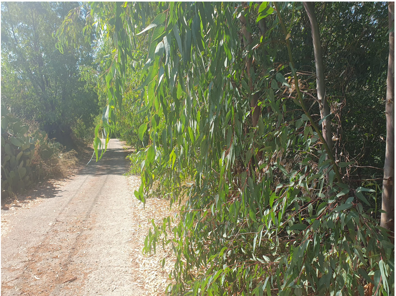
Foto 11: Valutazione dell'invasione della vegetazione sul sentiero e delle condizioni di manutenzione e sicurezza stradale
