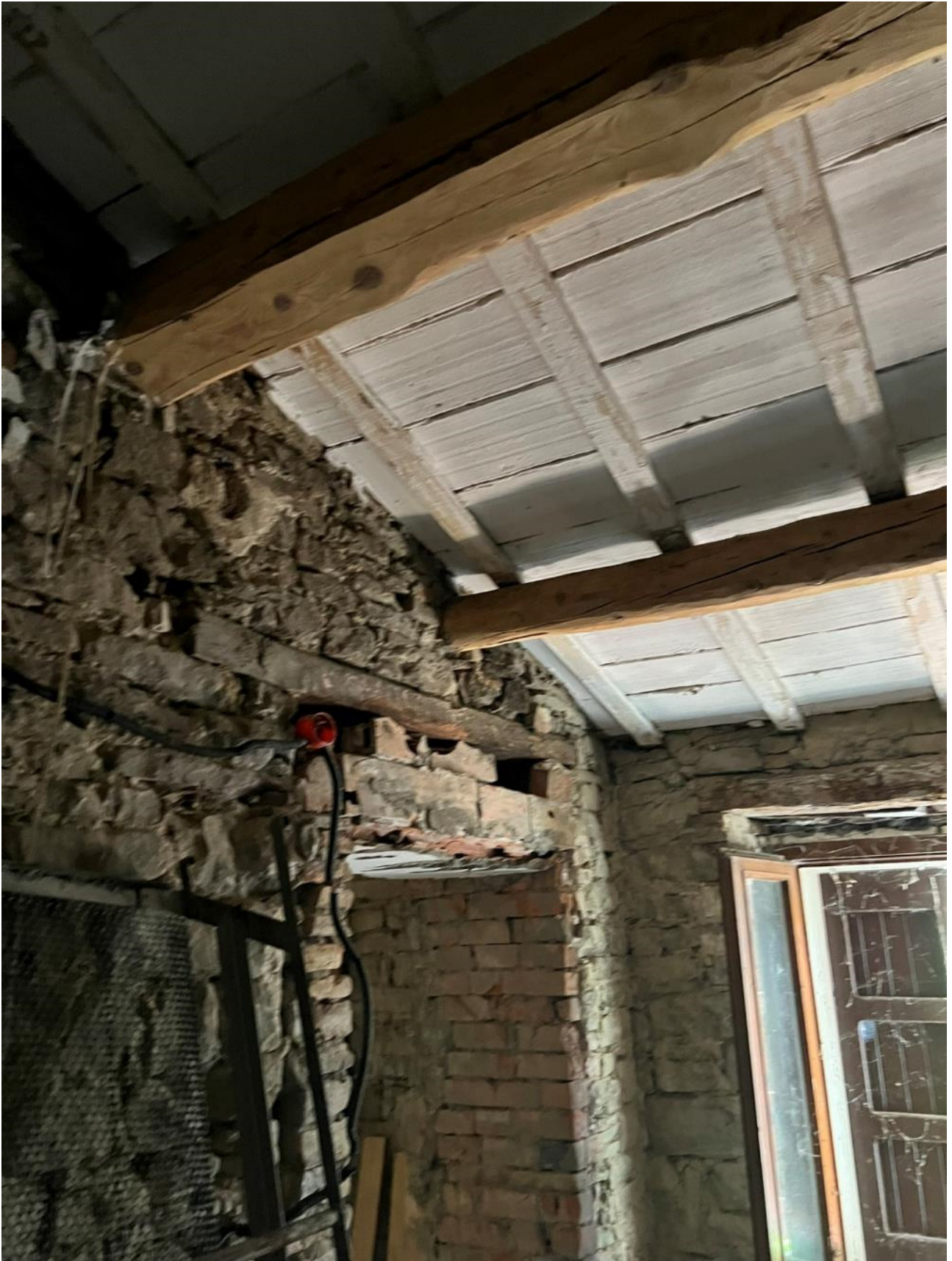
Fot. 15 – Vista dello stato edilizio attuale del piano primo.
