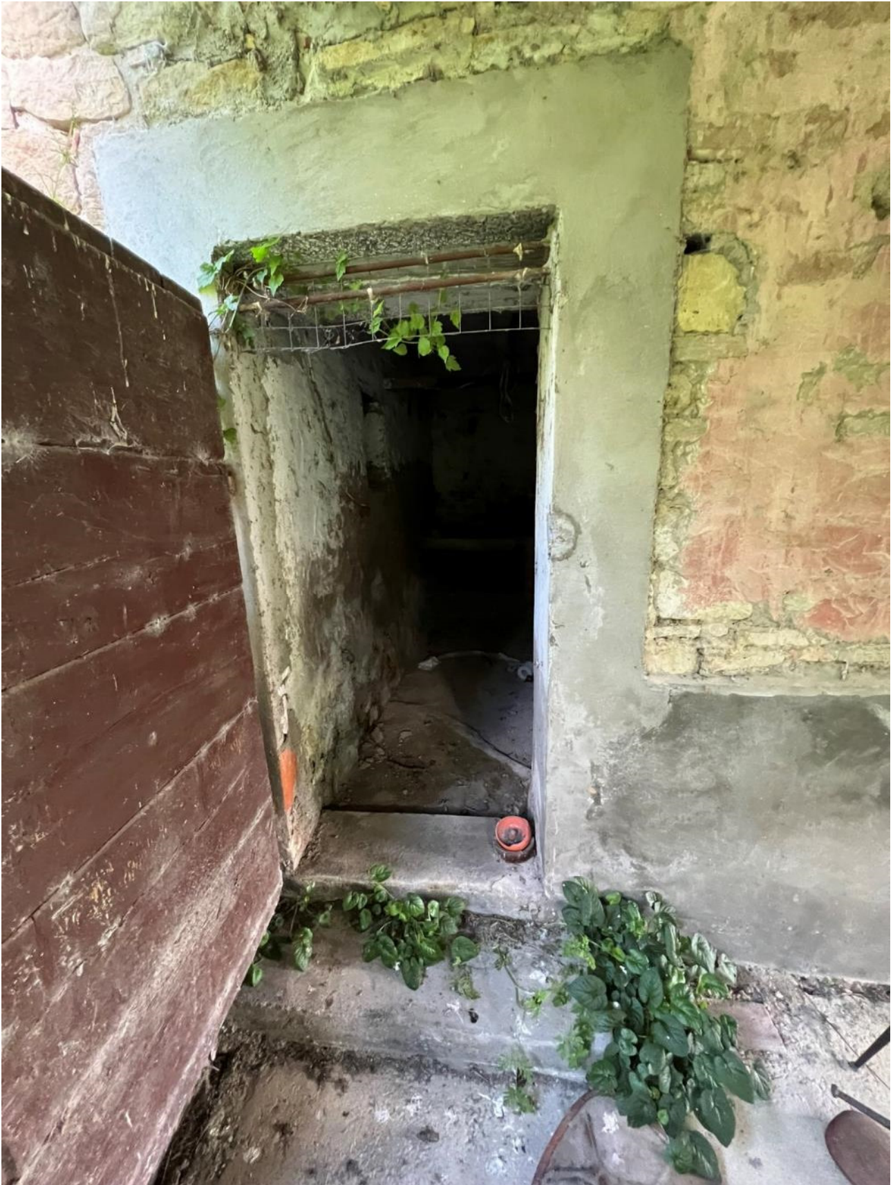
Fot. 06 – Vista della porta di ingresso alla cantina del piano terra.
