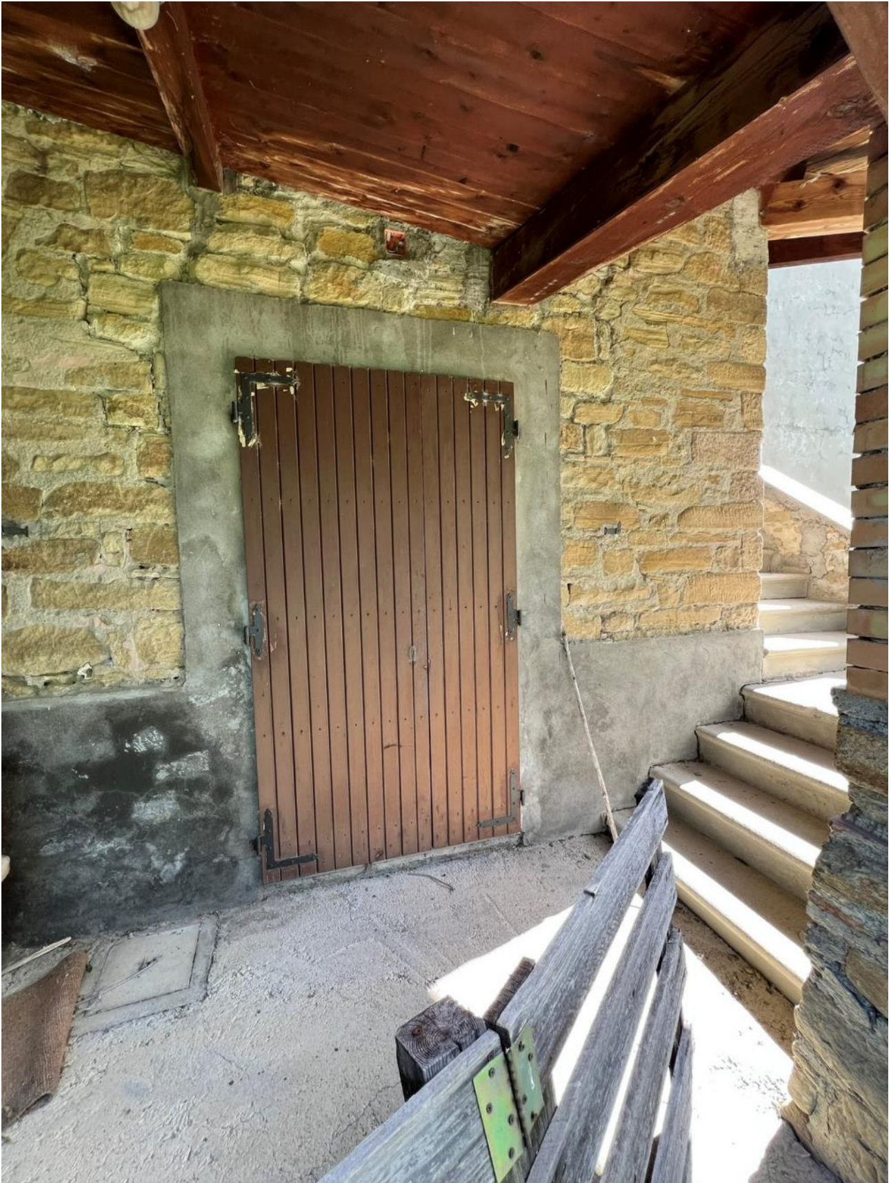
Fot. 05 – Vista della porta di ingresso al piano terra.
