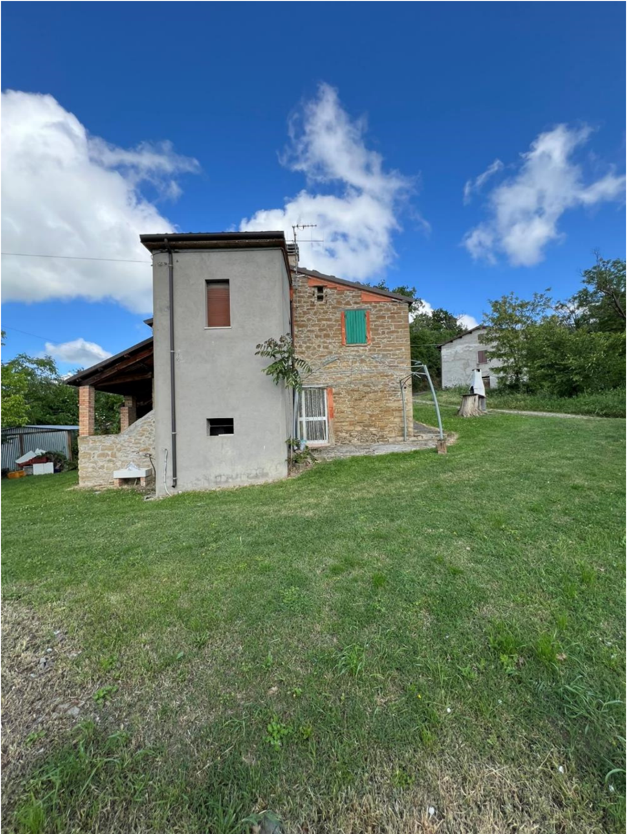
Fot. 03 – Vista dell’edificio dalla parte tergale. La porzione di sinistra, compreso il manufatto intonacato, costituisce l’unità immobiliare oggetto di procedura esecutiva.
