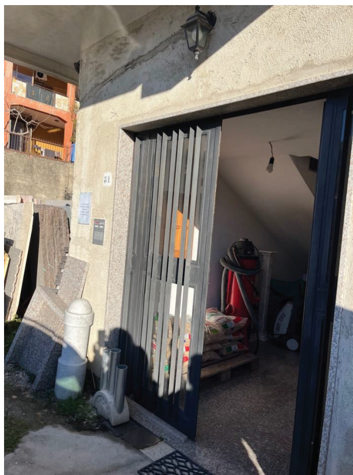
Foto 2 – Vista esterna del fabbricato
