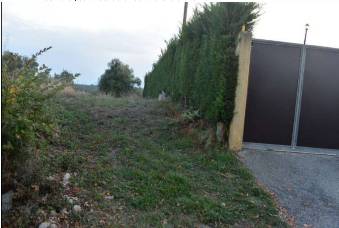
Foto N. 21: Idem c.s., con vista della recinzione lato Sud-Est
