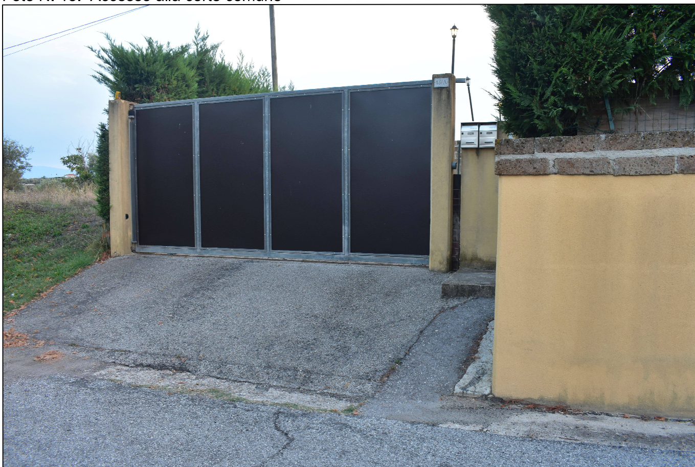
Foto N. 18: Accesso alla corte comune
