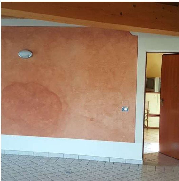
Figura 6: I5 - Accesso all'appartamento
