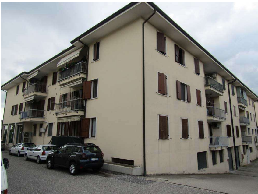
Foto 5: scorcio sul lato sud-est del fabbricato
