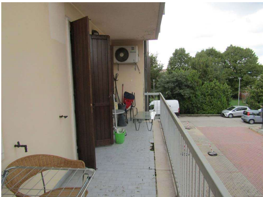
Foto 7: scorcio sul balcone a nord
