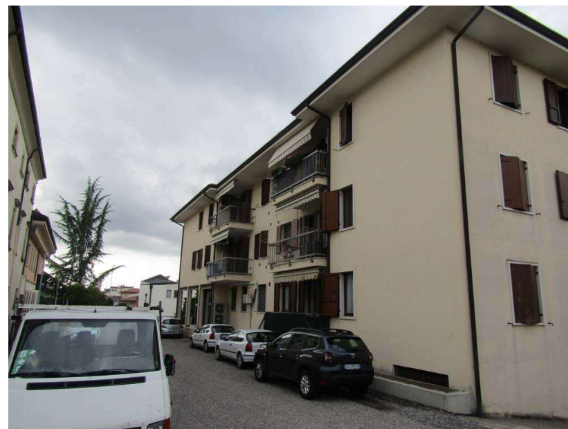
Foto 6: vista del prospetto sud del fabbricato
