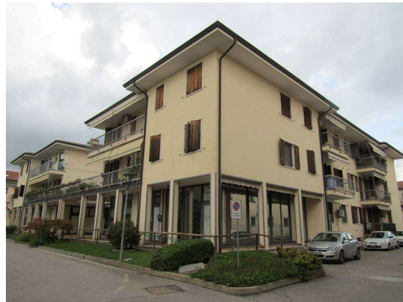
Foto 2: vista d'insieme di Via Tessari da sud-ovest
