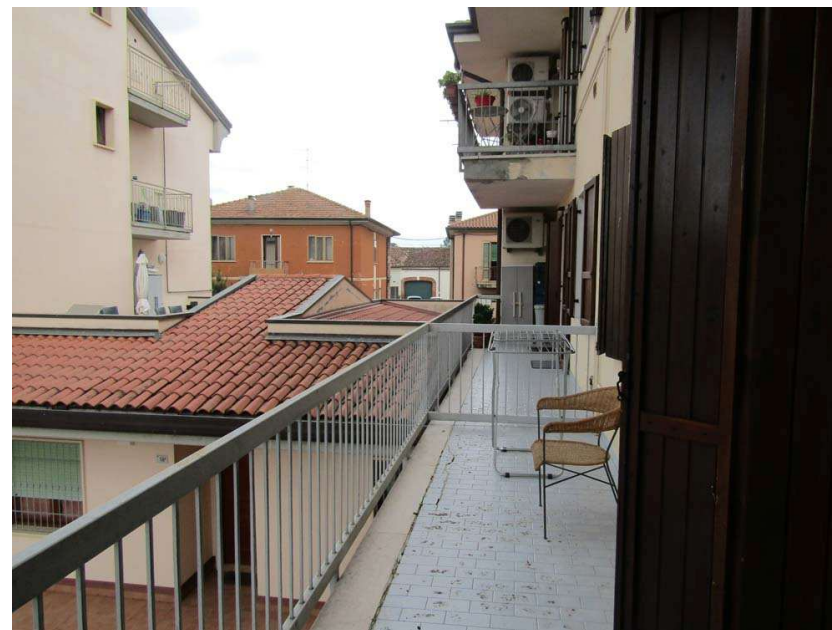
Foto 8: altro scorcio sul balcone a nord
