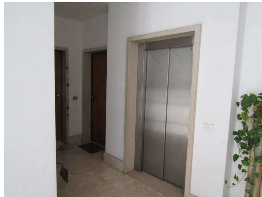
Foto 24: vista della zona ingresso condominiale al primo piano
