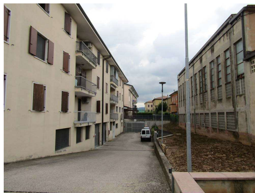
Foto 4: vista della corsia carraia a est del fabbricato
