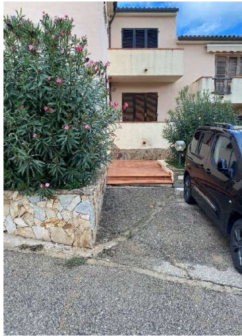
Foto N. 2: Prospetto laterale immobile.
