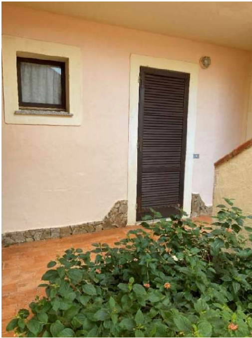
Foto N. 1: Prospetto su ingresso
