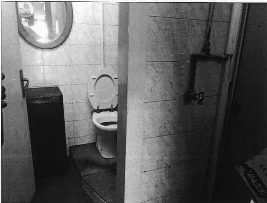
Foto 6—Inquadratura fotografica del vano wc, con annesso disimpegno.
