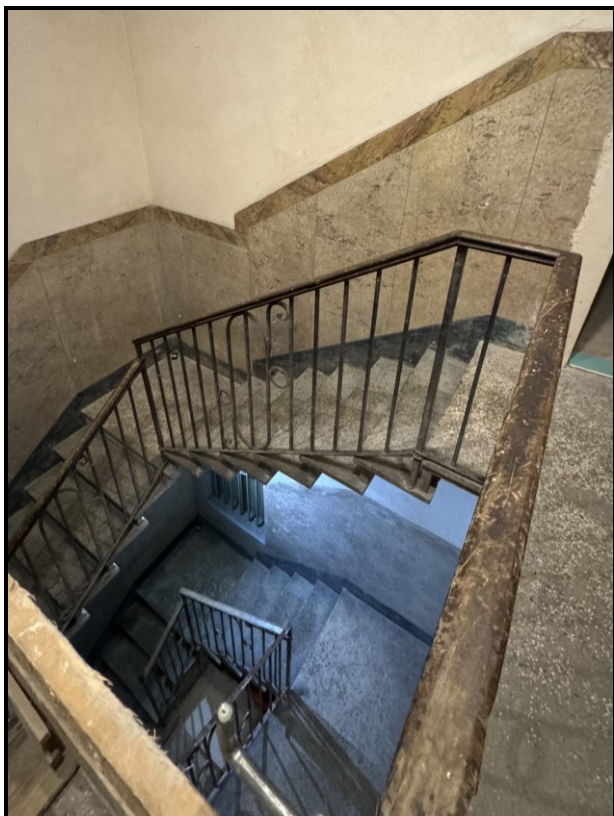
Foto 3: Il vano scala condominiale.
