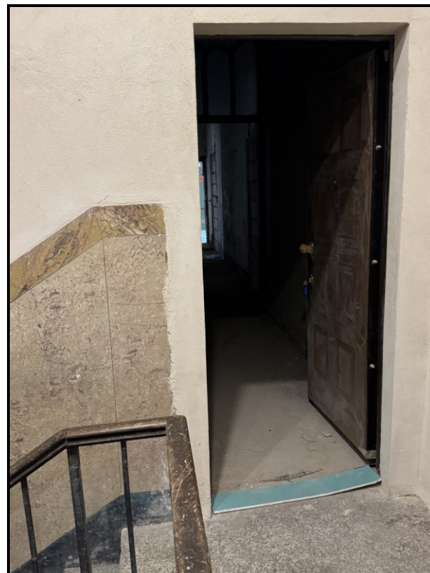
Foto 4: L'ingresso dal vano scala condominiale.
