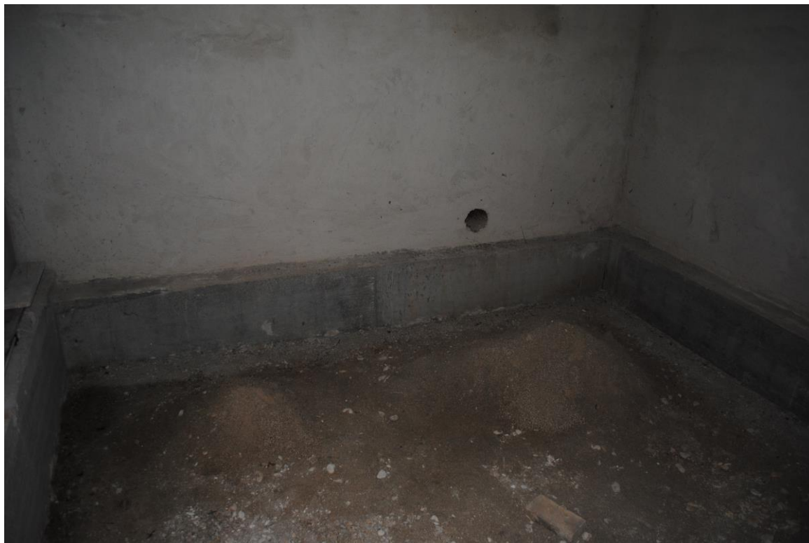
Foto n. 24 – vista interna piano interrato - cantina
