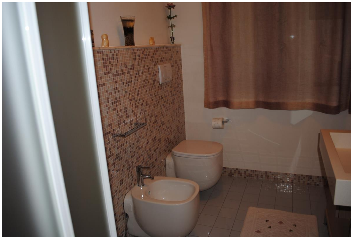
Foto n. 21 – vista interna piano interrato - bagno
