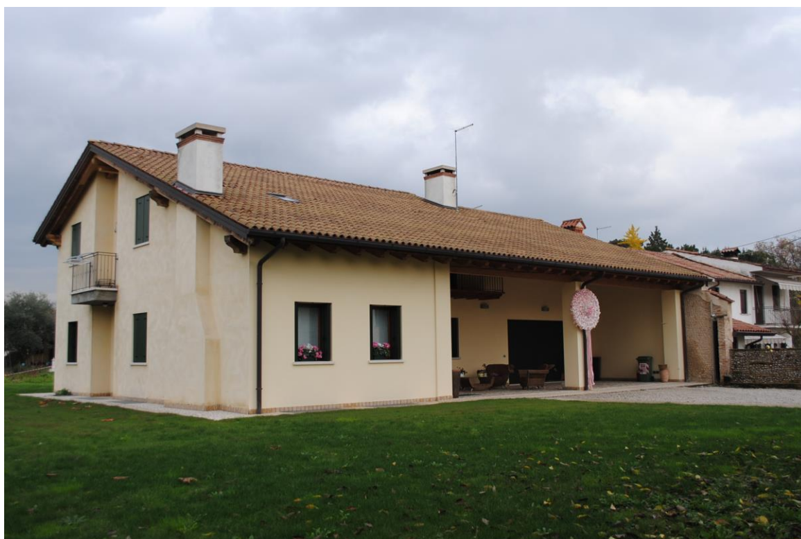
Foto n. 3 – vista da sud-ovest
