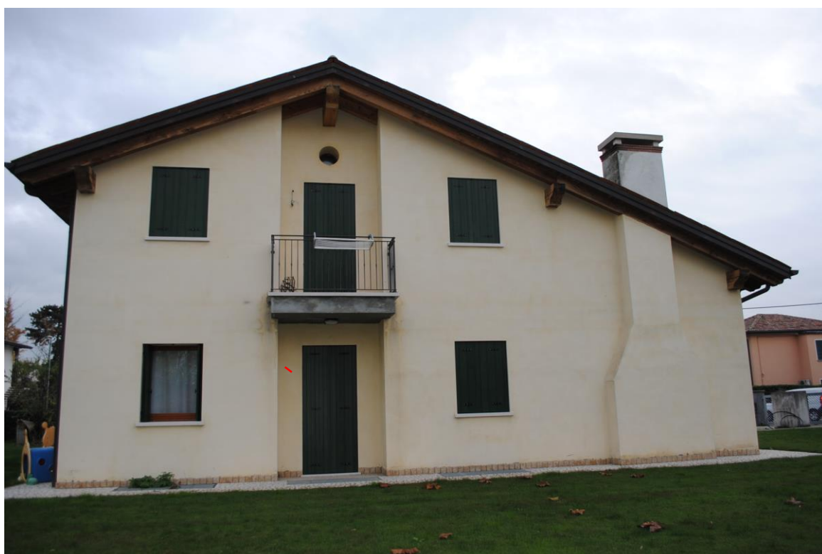
Foto n. 4 – vista da ovest
