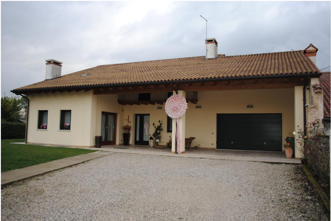
Foto n. 2 - vista da sud
