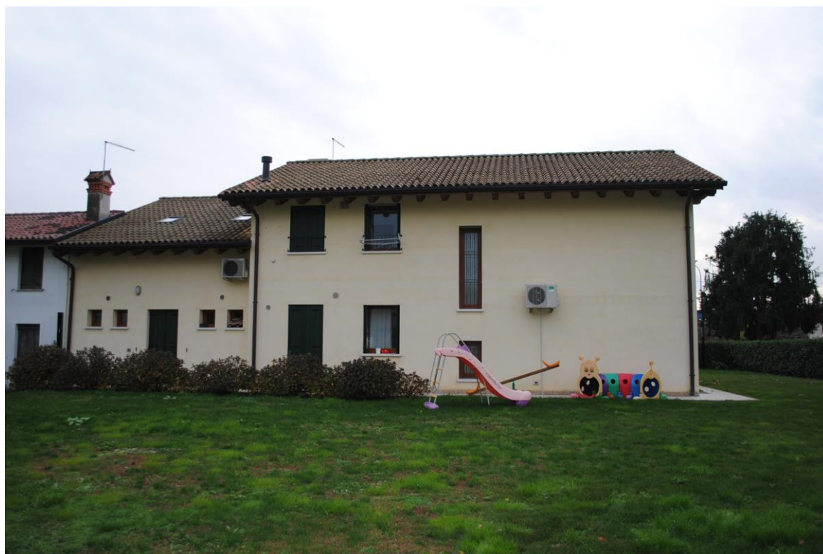
Foto n. 6 – vista da nord
