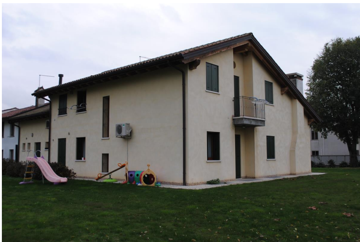
Foto n. 5 – vista da nord-ovest
