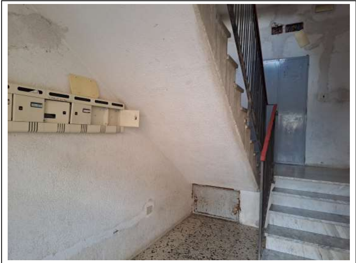
Foto n. 3 – Immobile sito in Palermo, Largo dell'Anitra n. 2, piano 2° - Corpo scala
