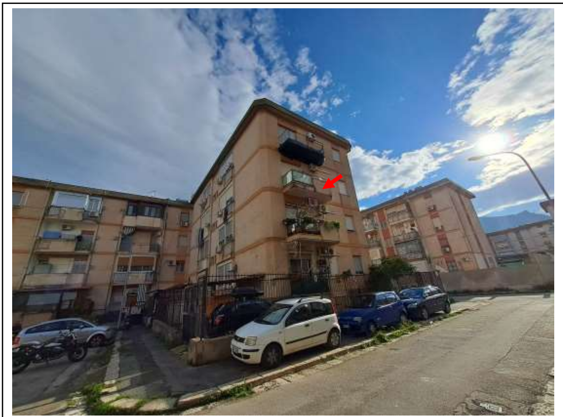
Foto n. 2 – Immobile sito in Palermo, Largo dell'Anitra n. 2, piano 2° - Prospetto laterale
