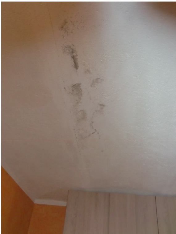
Tracce infiltrazioni
