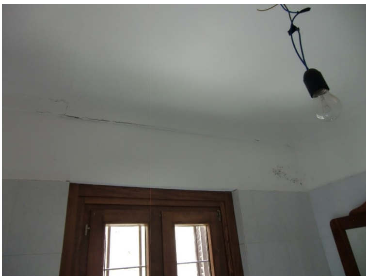
Tracce infiltrazioni
