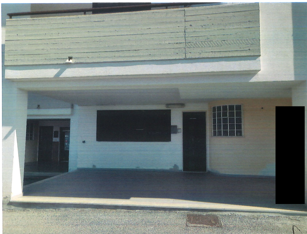
Ingresso Piano Terra
