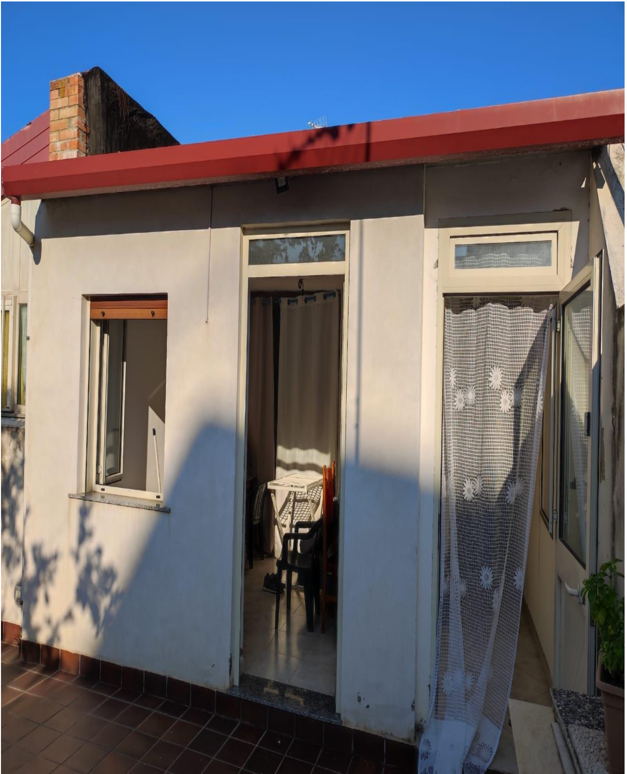
VISTA DA CORTILE
