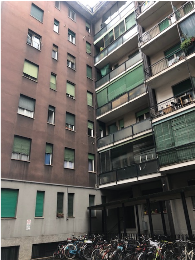
SCALA B - INGRESSO
