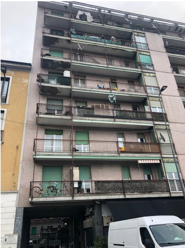
ACCESSO PRINCIPALE DA VIA ROGOREDO
