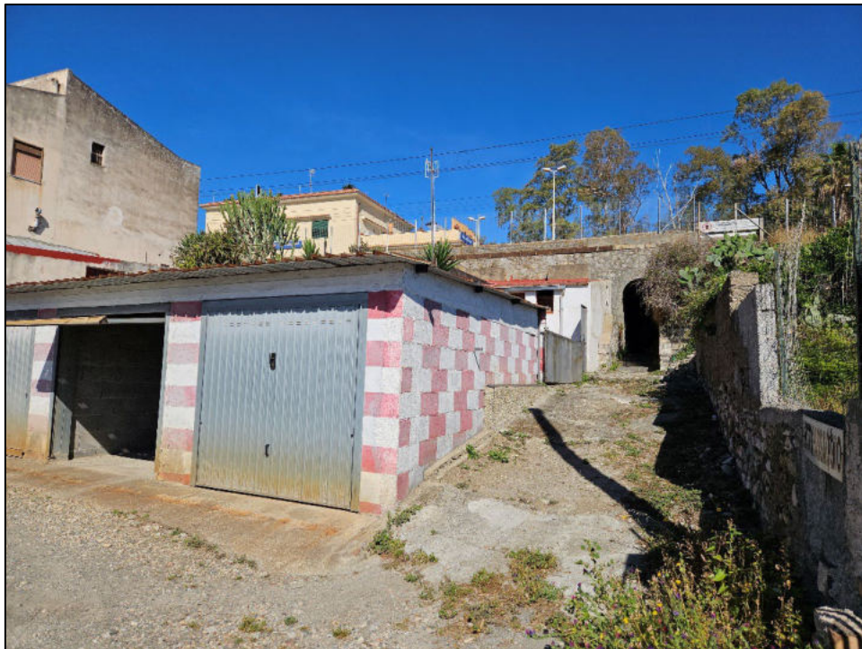
Foto 24: Vista di scorcio box-auto e sottopasso ferroviario.
