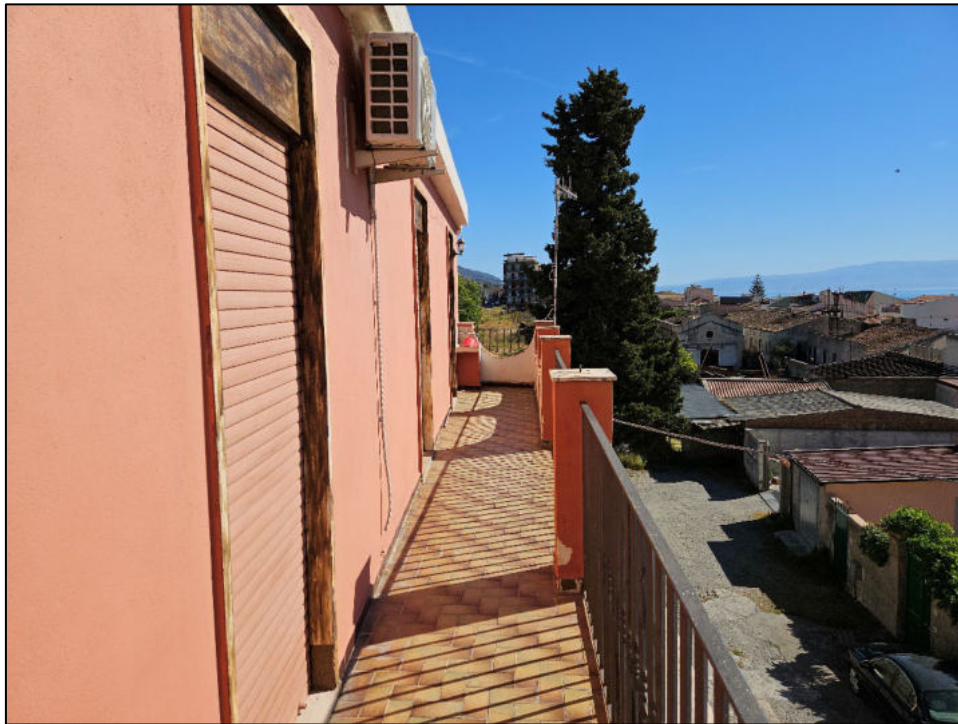
Foto 19: balcone lato sud-est (primo piano).
