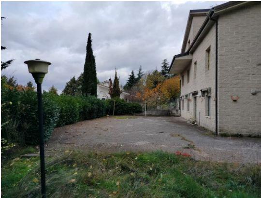
Piazzale piano terra
