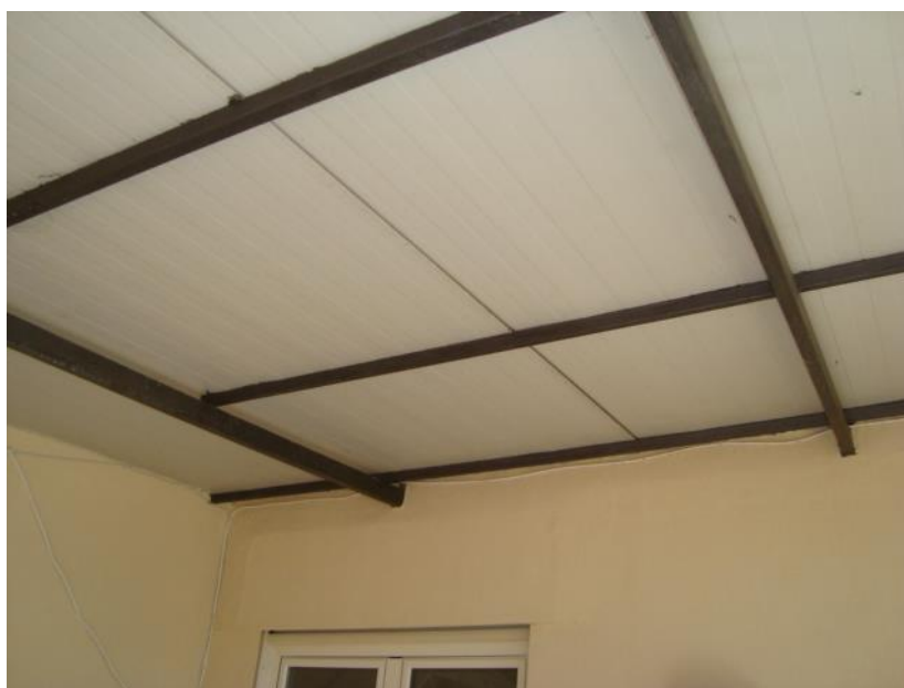
Foto n. 16 – Particola della copertura del terrazzo
