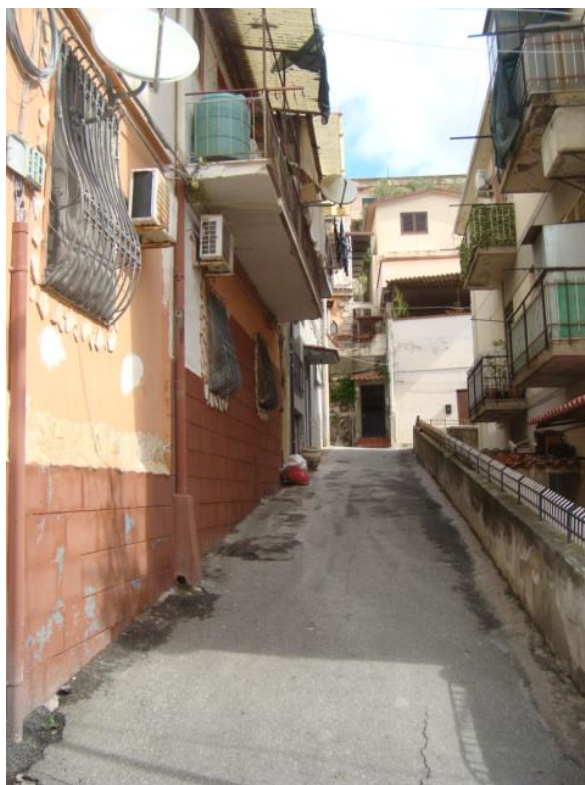
Foto n. 3 – Prospetto e ingresso dalla via 41C
