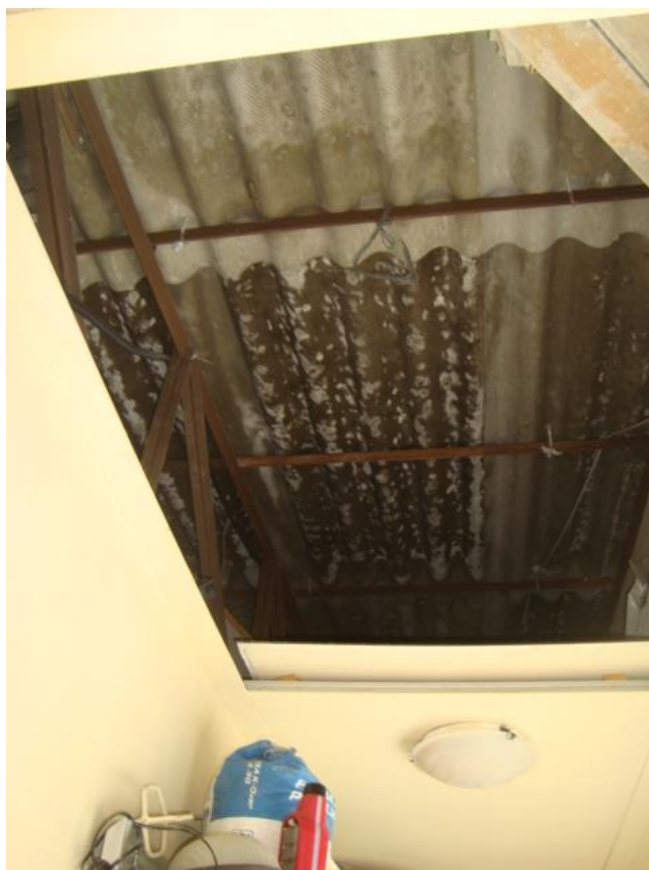
Foto n. 15 – Particolare della copertura con lastre di amianto
