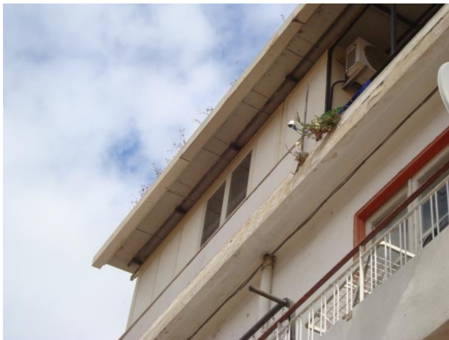
Foto n. 2 – Dettaglio Prospetto su via Cherubini
