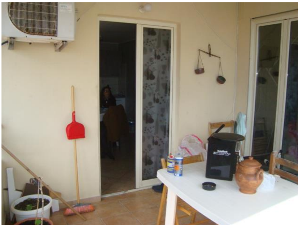
Foto n. 13 – Terrazzo con copertura
