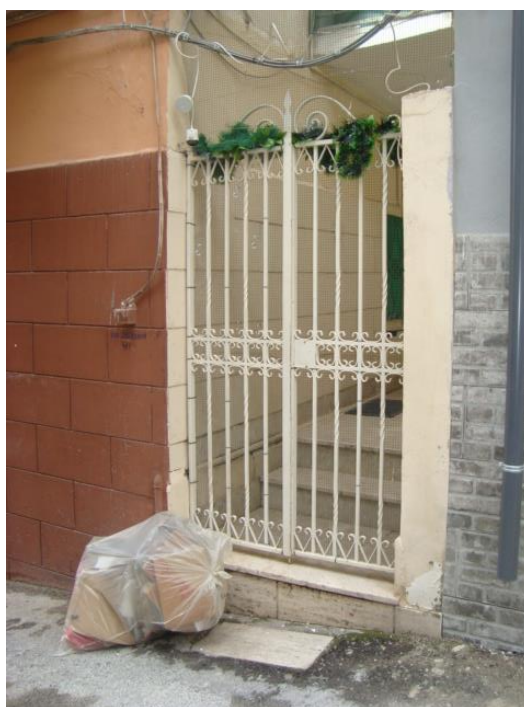
Foto n. 4 – Prospetto e ingresso dalla via 41C
