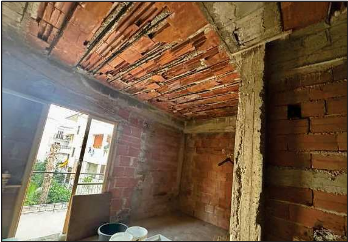
fig.11 – solaio copertura primo piano.
