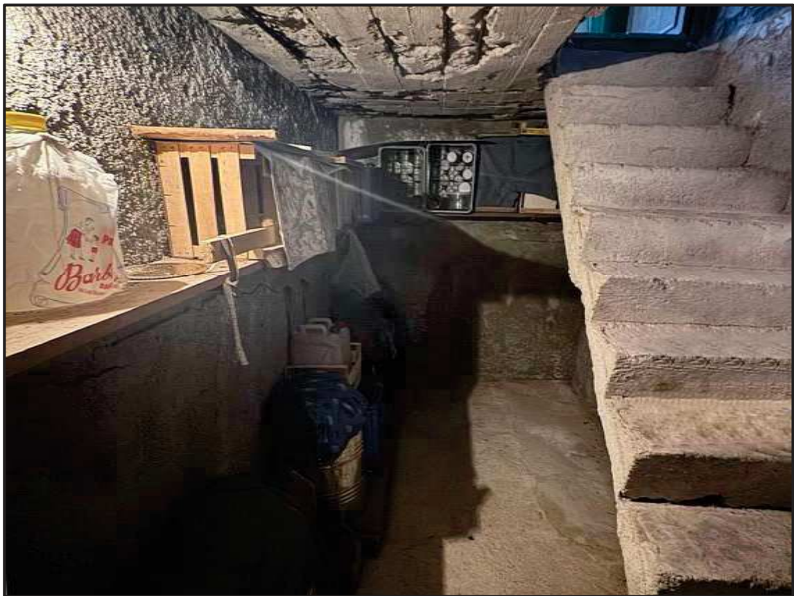
fig.8 – piccolo vano cantinato.
