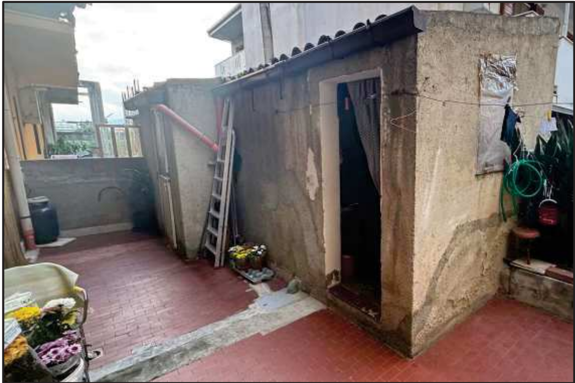
fig.7 – manufatto in muratura corte piano terra.
