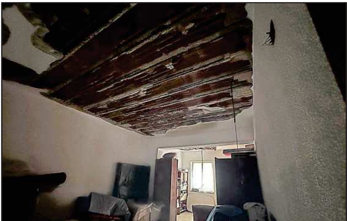
fig.12 – solaio copertura primo piano vano rifinito.
