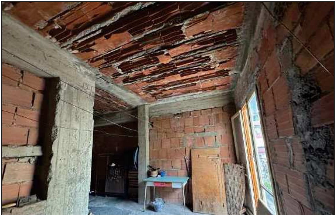
fig.10 – solaio copertura primo piano.
