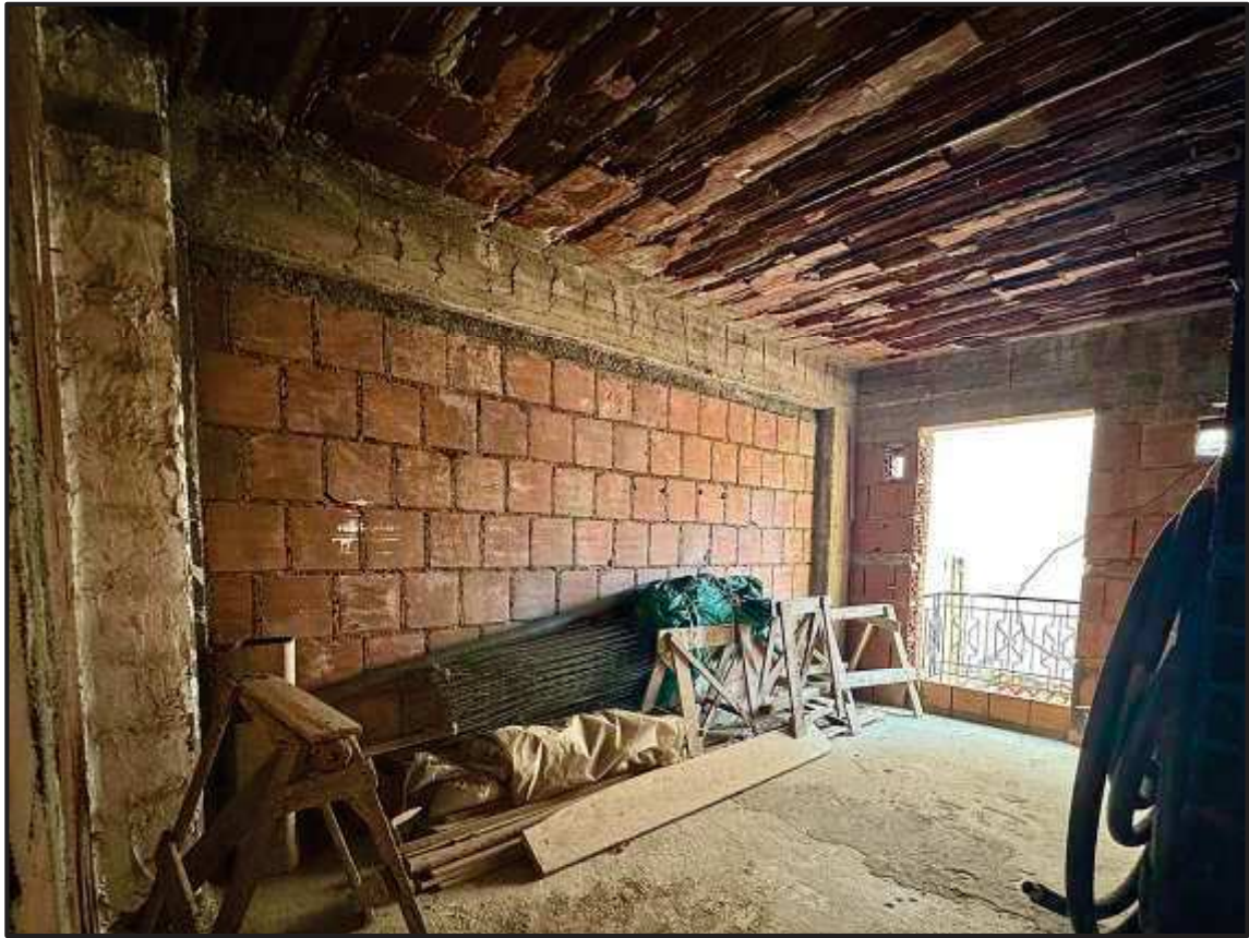
fig.9 – solaio copertura primo piano.
