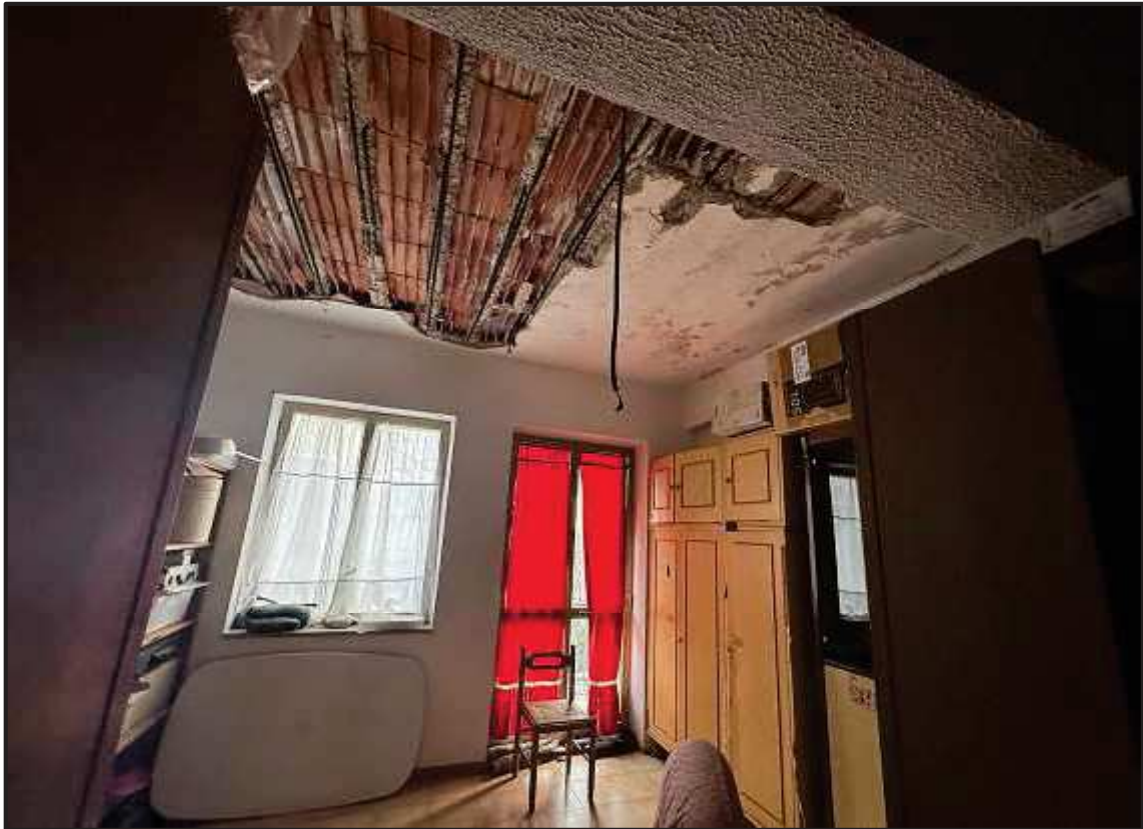
fig.13 – solaio copertura primo piano vano rifinito.
