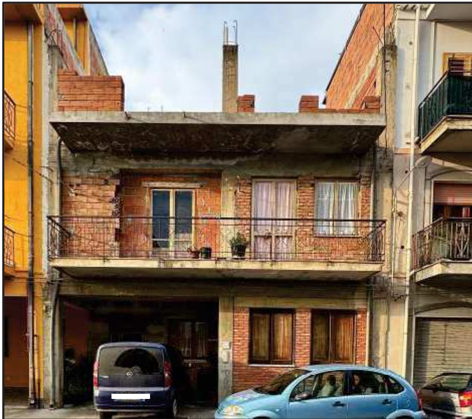
fig.2 – Immobili oggetto di causa
