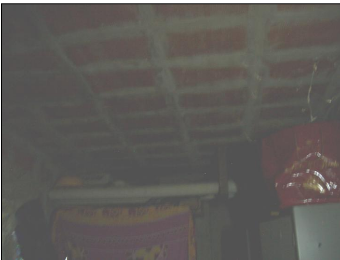
Vista interna cantina
