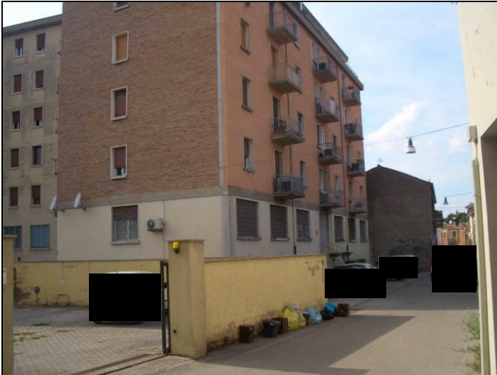
Vista esterna condominio da Via Pesa Vecchia
