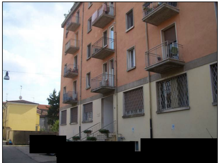
Vista esterna condominio da Via Pesa Vecchia
