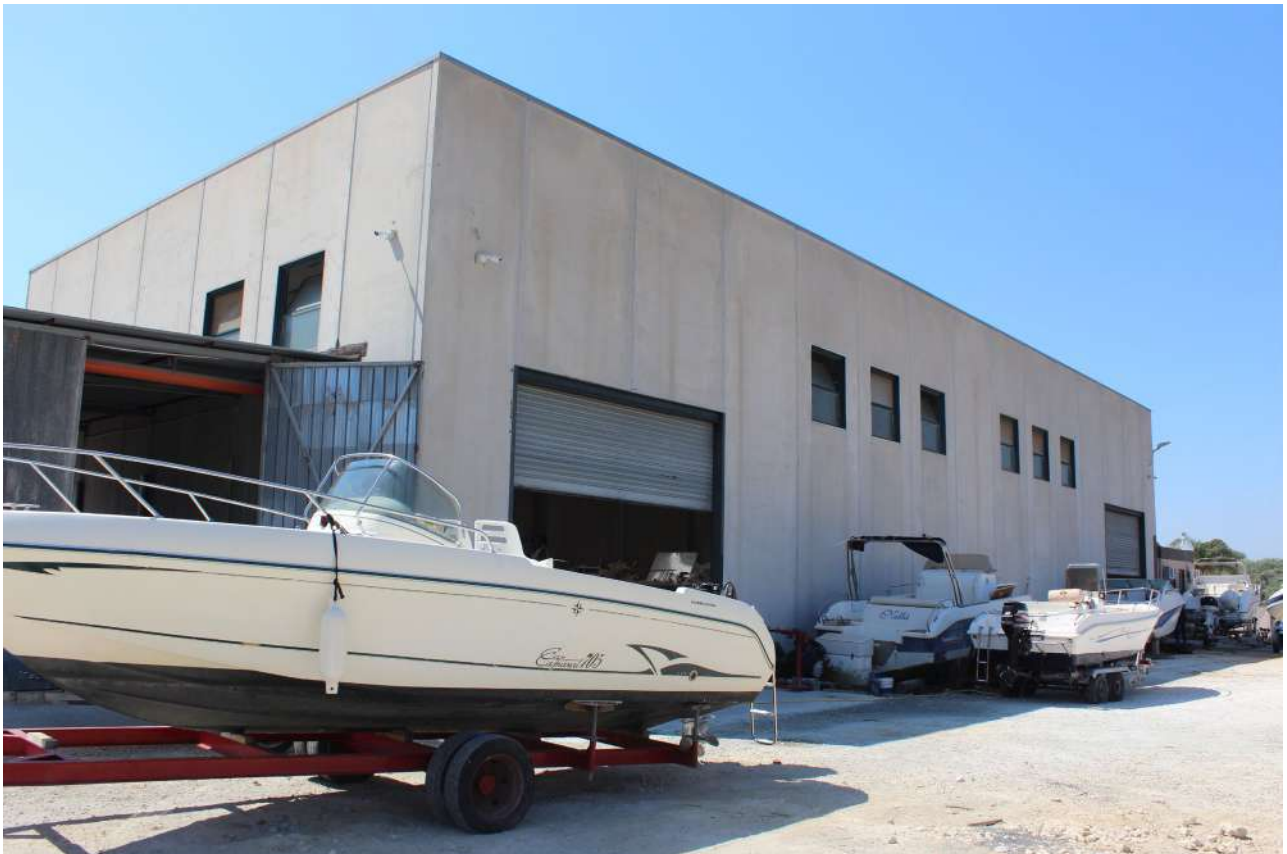
Foto n. 6 – Vista laterale capannone e struttura precaria in lamierino
