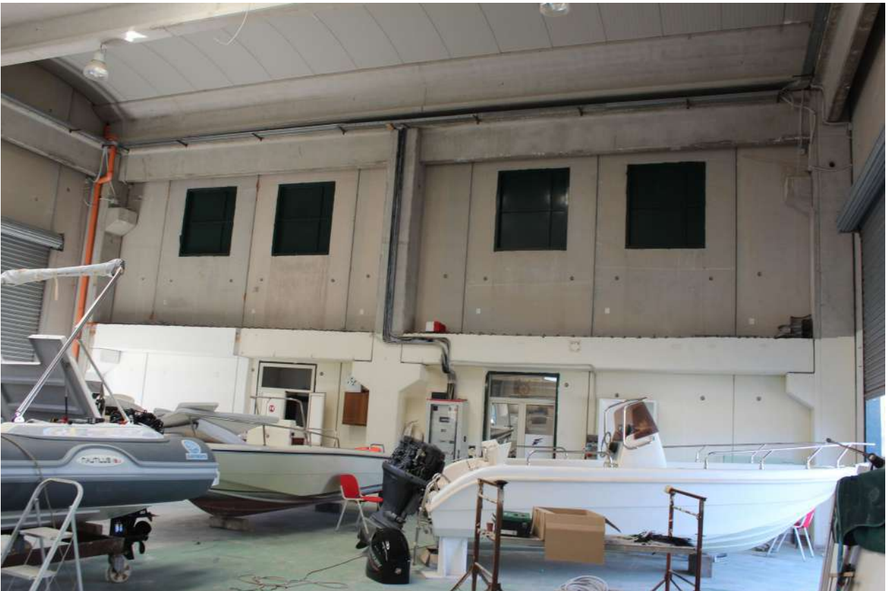
Foto n. 12 – Vista capannone rimessaggio barche interno
