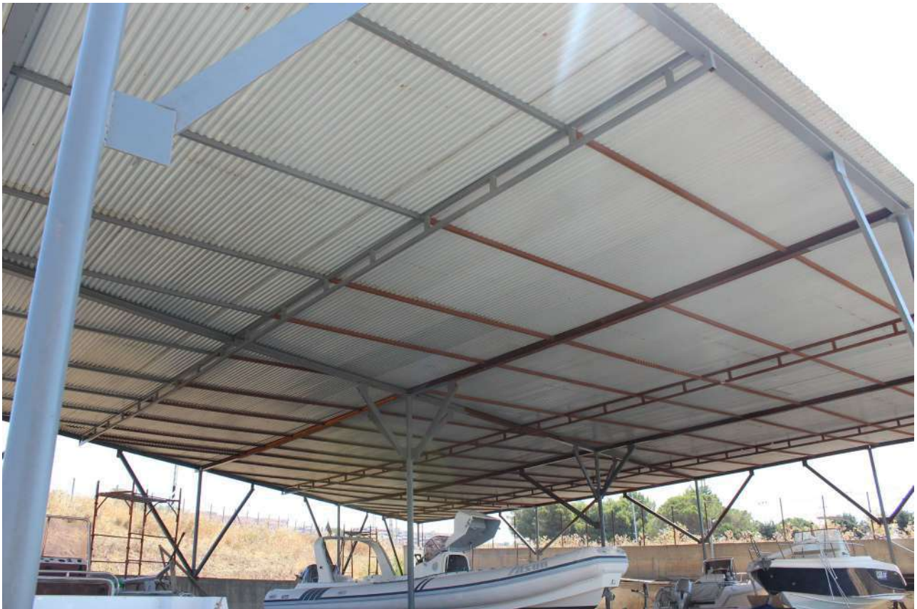
Foto n. 8 – Vista tettoia coperta in profilato di ferro
