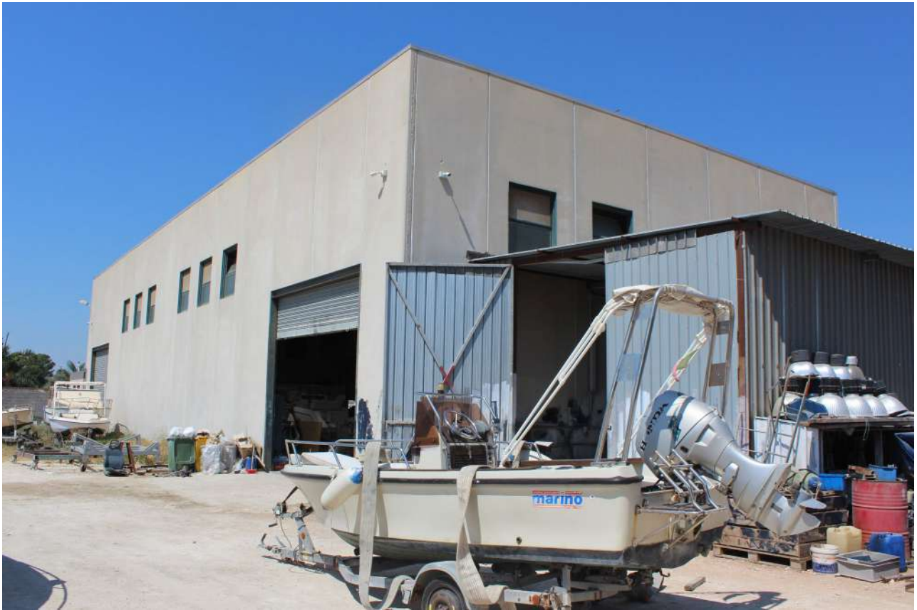
Foto n. 3 – Vista Capannone adibito rimessaggio barche
