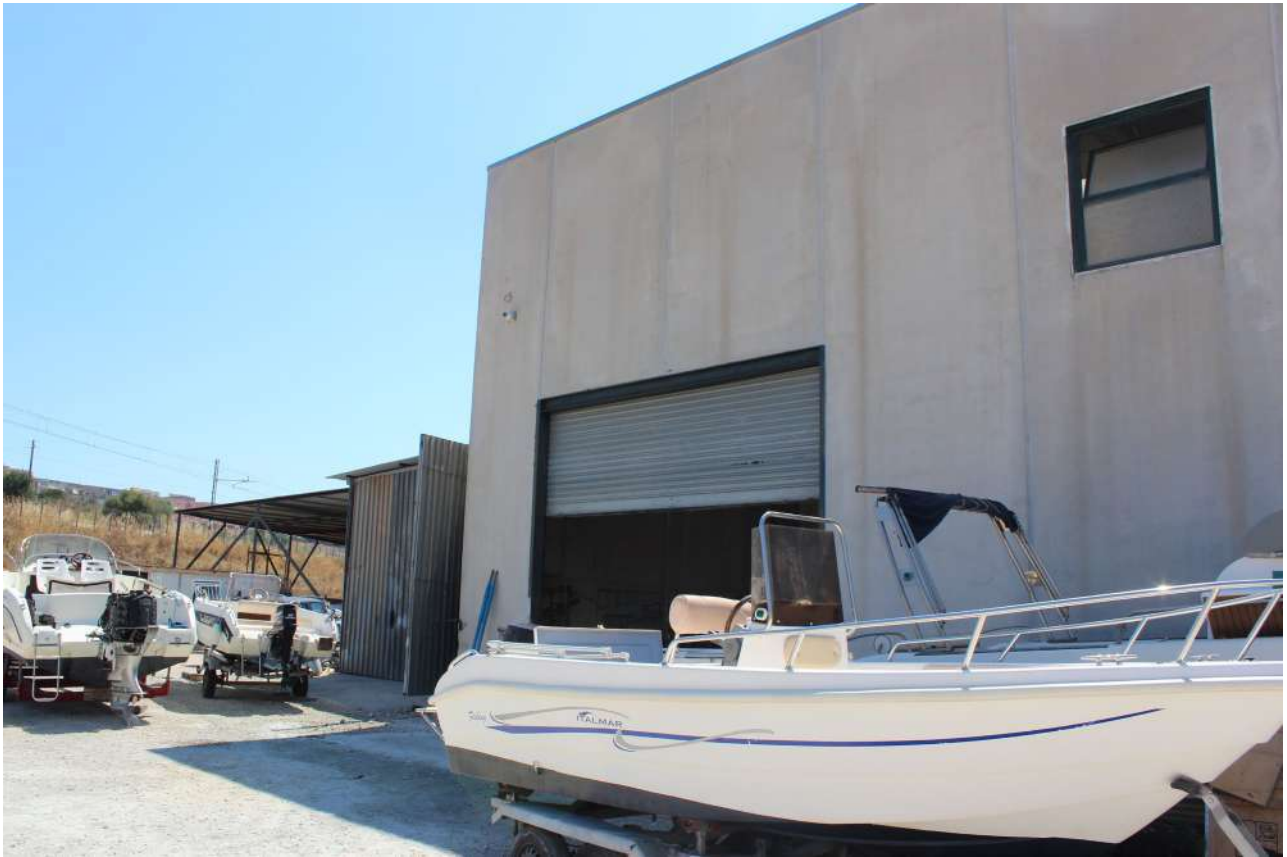
Foto n. 7 – Vista laterale capannone e struttura precaria in lamierino
