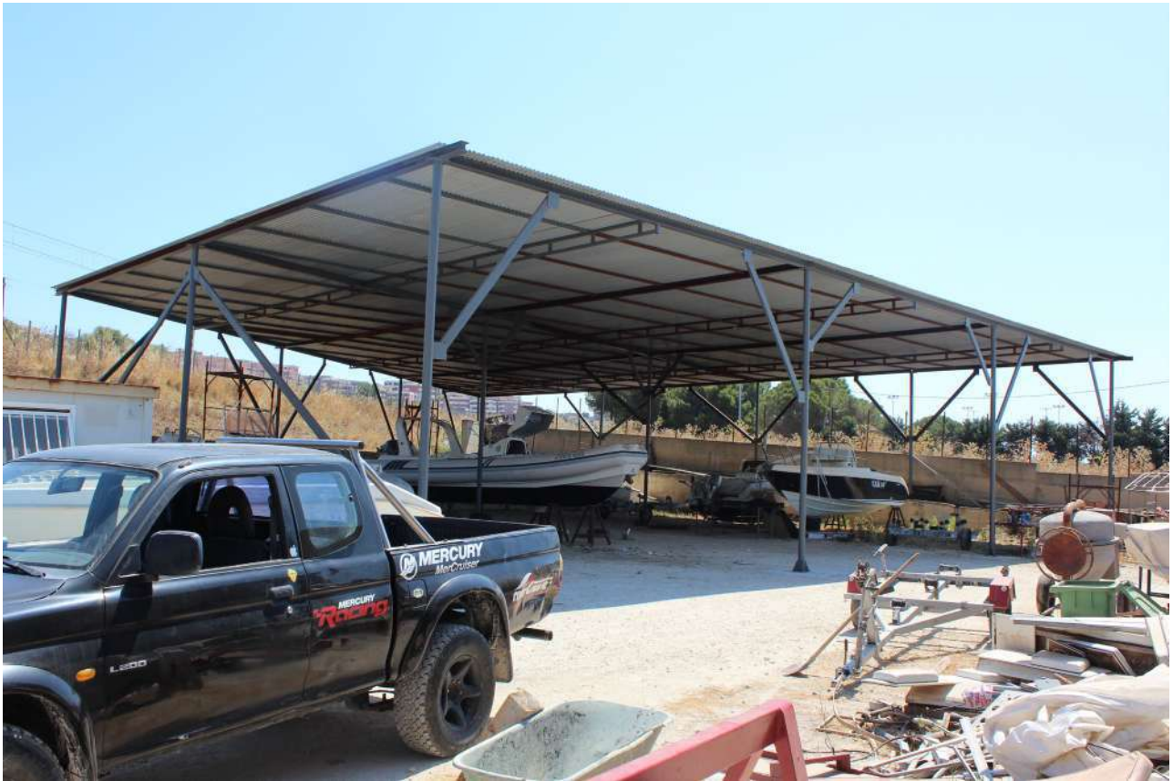
Foto n. 9 – Vista tettoia coperta in profilato di ferro
