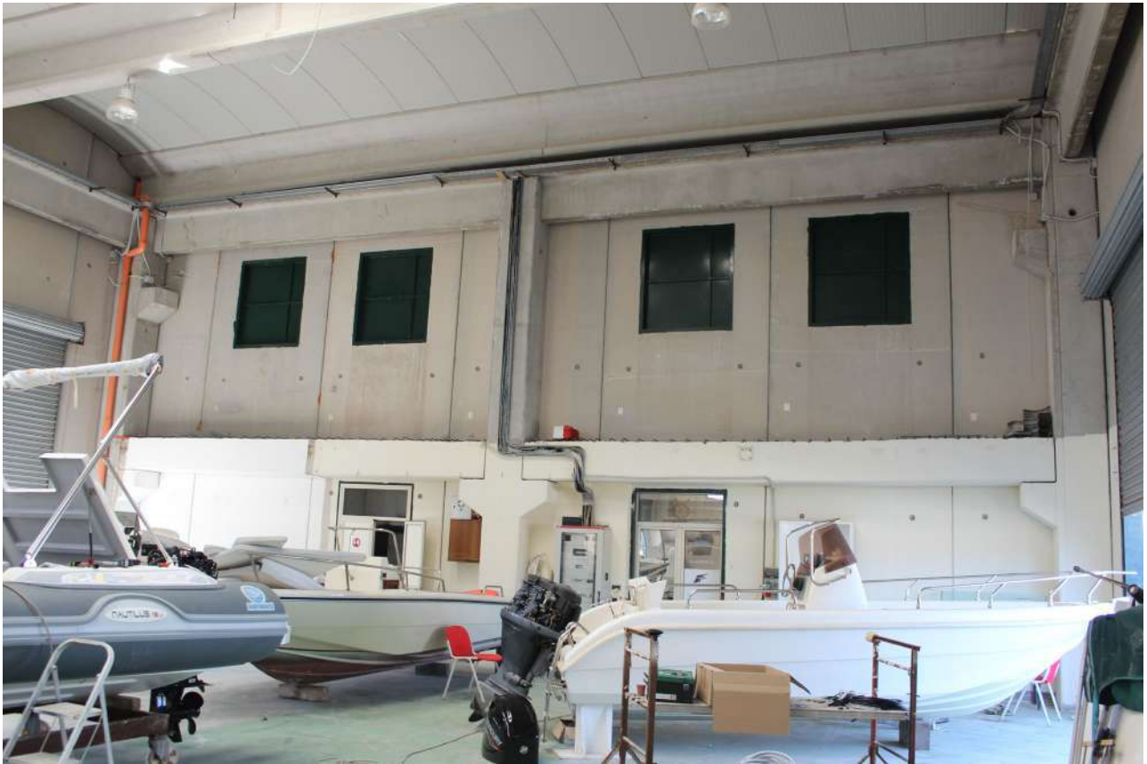
Foto n. 13 – Vista capannone rimessaggio barche interno
