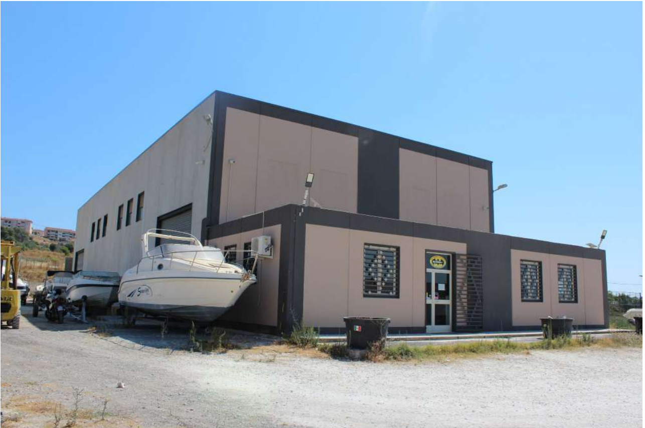
Foto n. 1 – Vista Capannone adibito rimessaggio barche
