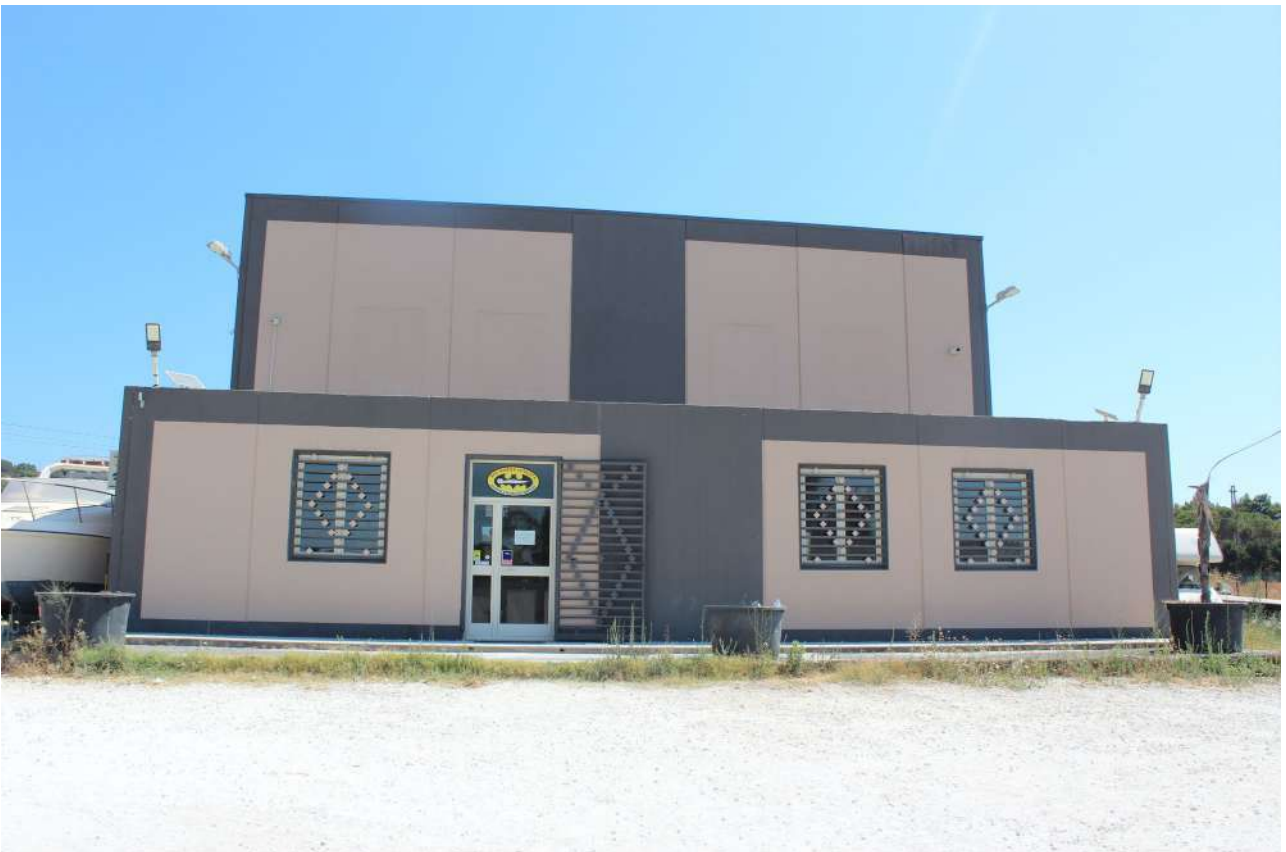
Foto n. 2 – Vista Capannone adibito rimessaggio barche
