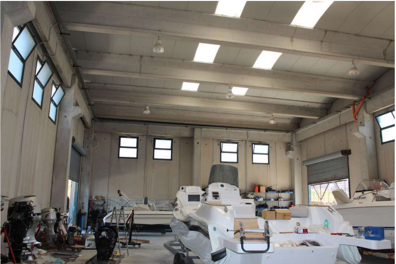
Foto n. 11 – Vista capannone rimessaggio barche interno
