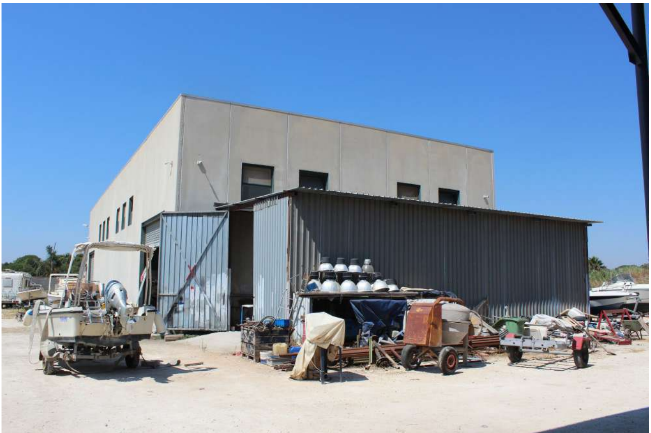
Foto n. 4 – Vista Capannone adibito rimessaggio barche
