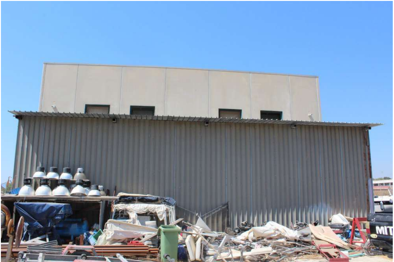
Foto n. 5 – Vista Capannone struttura precaria in lamierino
