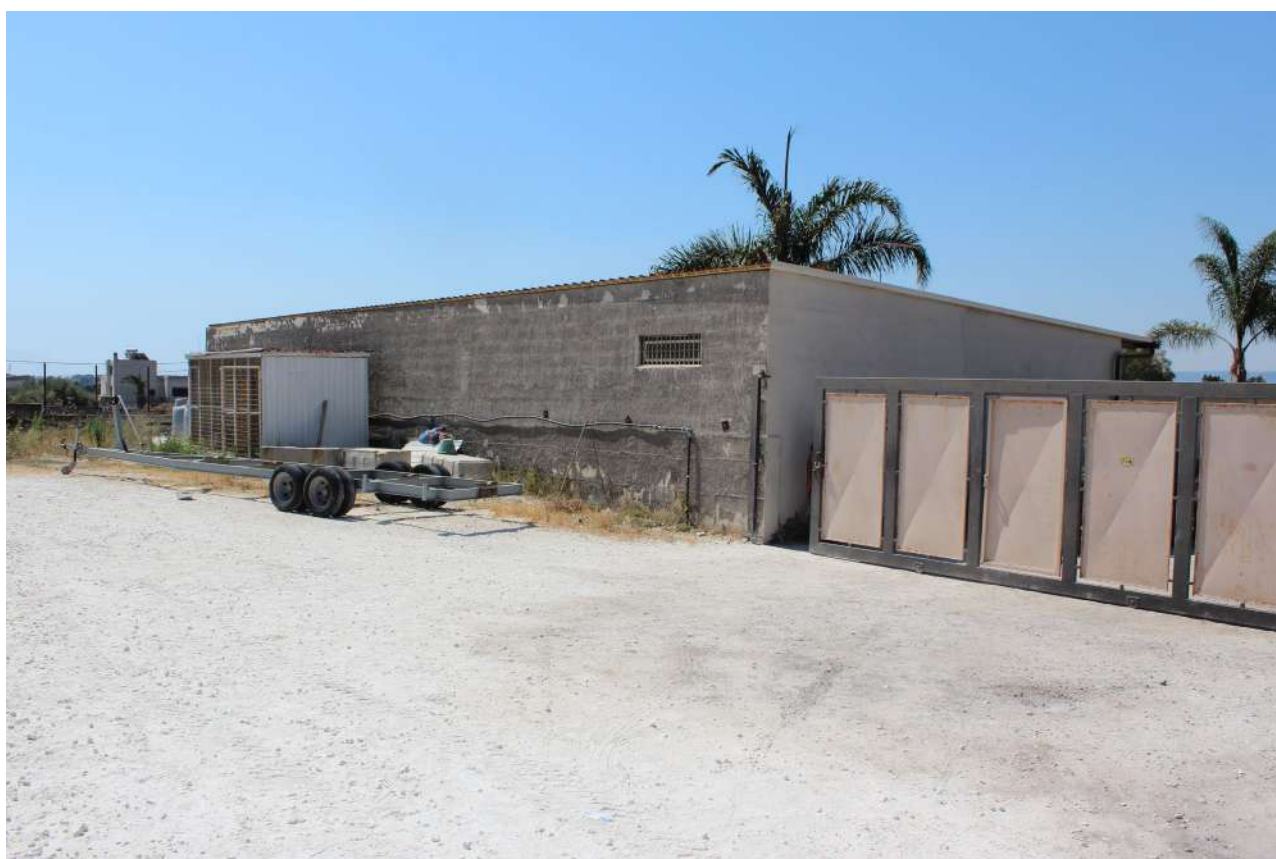
Foto n. 18 – Vista cancello d'accesso capannone e vista laterale laboratorio artigianale
