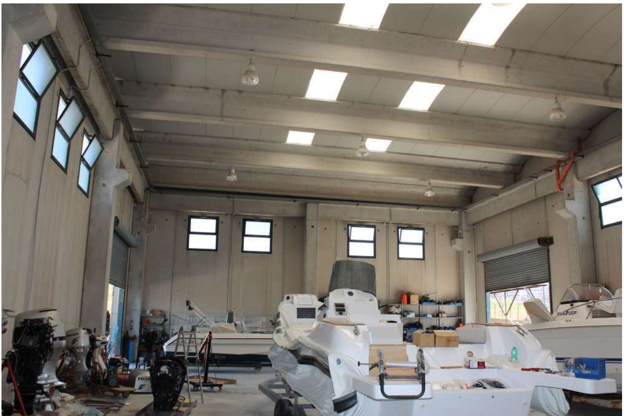
Foto n. 10 – Vista capannone rimessaggio barche interno
