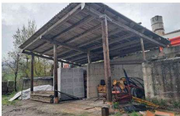
Figura 28: esterno 11 D tettoia irregolare Prospetto Nord Est ripresa ad altezza del campo
