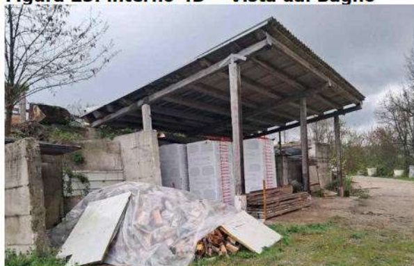
Figura 27: esterno 10 D tettoia irregolare Prospetto Sud Est ripresa ad altezza del campo
