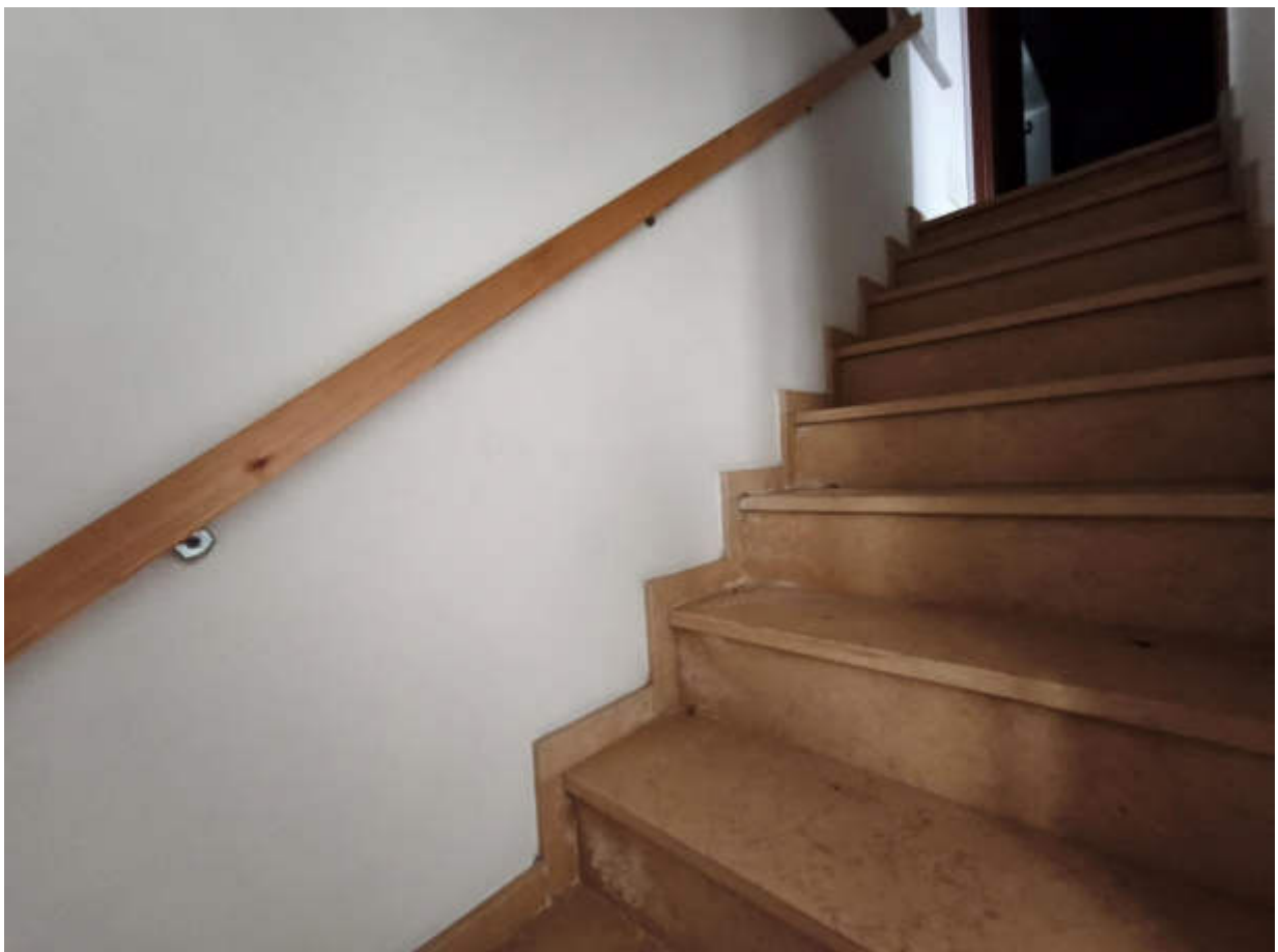
Fotografia 8: scala di collegamento tra piano terra e primo
