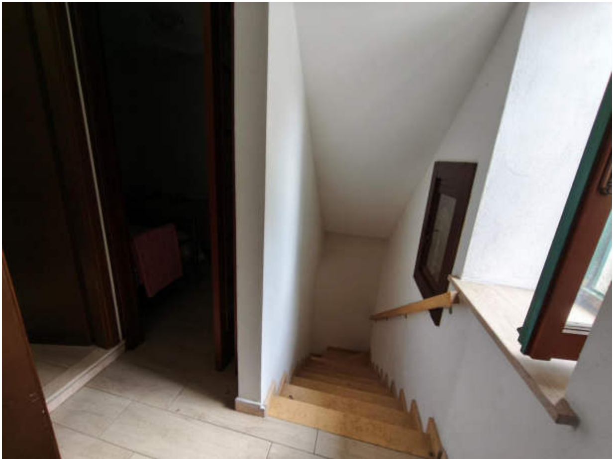
Fotografia 9: scala di collegamento tra piano terra e primo vista dall'alto
