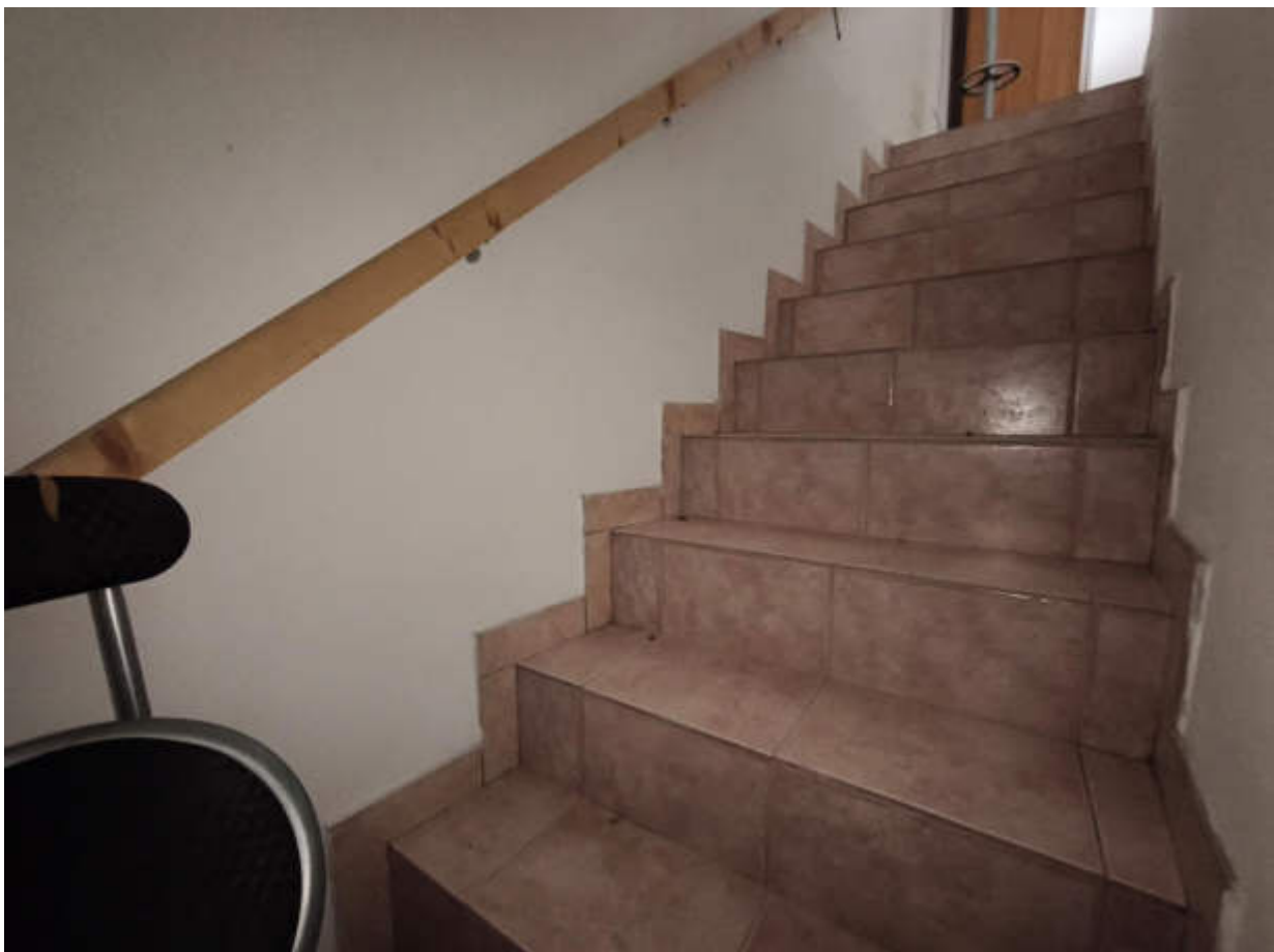
Fotografia 14: scala di collegamento tra piano primo e sottotetto
