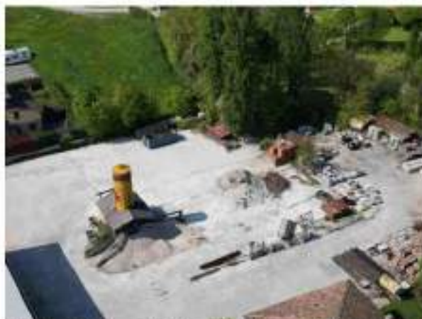
Figura 72: esterno 9 B - vista aerea dell'area cortiliva sia per lo stoccaggio dei materiali che per la lavorazione del cemento
