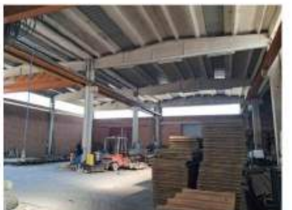
Figura 78: interno 4B - Vista dell'ampliamento del capannone (parte nuova) ove è visibile la presenza di carro ponte
