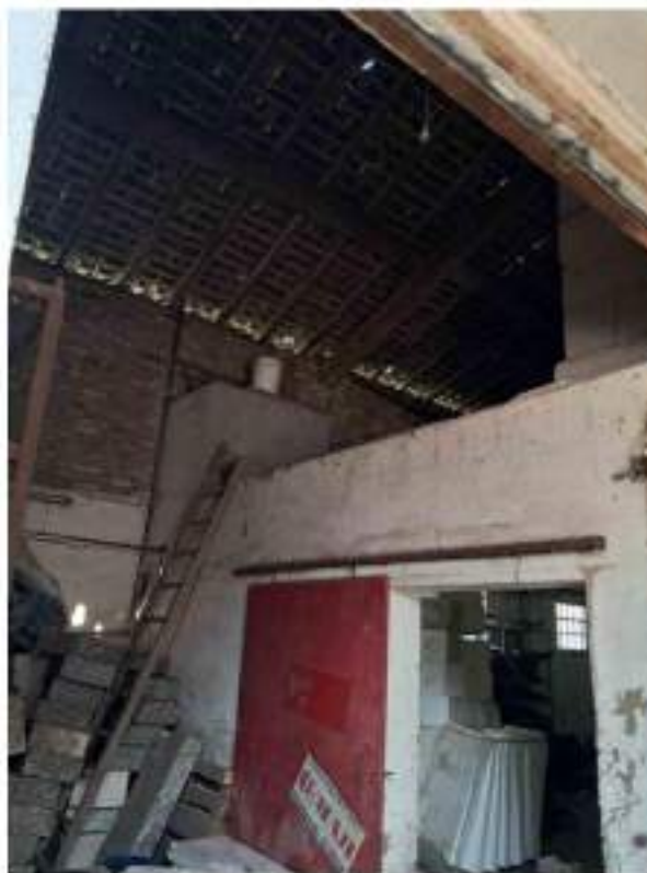
Figura 62: interno 10 A - Doppio volume officina e soppalco
