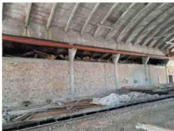
Figura 76: interno 2B - Vista interna del capannone ove è possibile osservare la struttura in c.a. con catene
