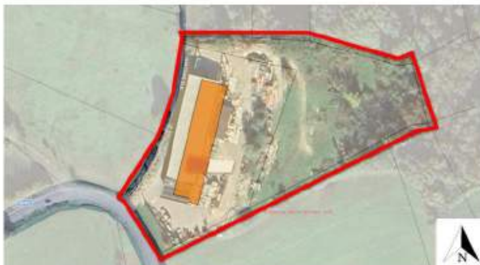
Figura 36: vista aerea delle Particelle oggetto di pignoramento identificate al Fg 2 mapp. 478 e 479 del Comune di Toano
