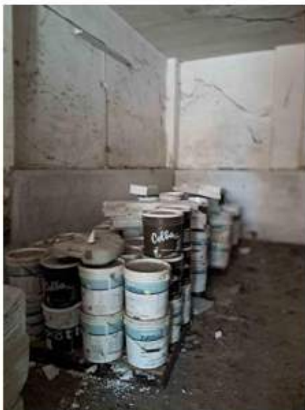
Figura 61: interno 9 A Autorimessa con impianto elettrico a vista
