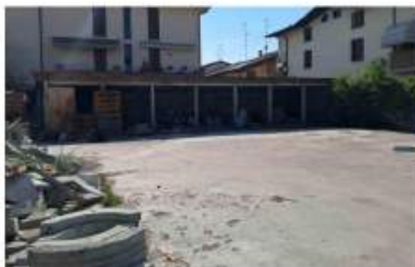
Figura 74: esterno 11B - Prospetto Nord della tettoia
