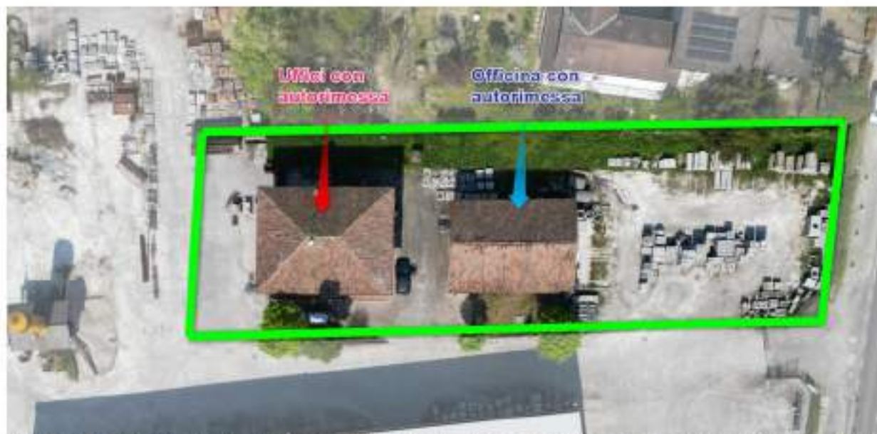
Figura 41: Esterno 0A - Vista aerea del lotto A - la freccia rossa indica l'immobile con uffici, autorimessa e servizi, la freccia azzurra l'officina con autorimessa
