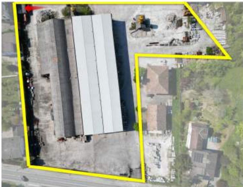
Figura 63: Esterno 0 B - vista aerea del lotto B, ove la Particella 153 è indicata dalla freccia rossa, mentre nel capannone al mappale 152, si evince che la porzione a sinistra ha la copertura in fibrocemento mentre la porzione a destra è stata oggetto di ristrutturazione nel 2015
