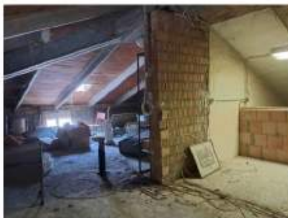
Figura 58: interno 6 A - Sottotetto Uffici
