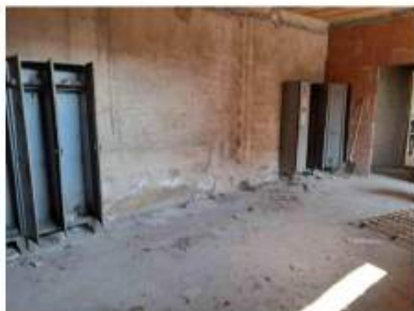
Figura 79: interno 5 B - zona spogliatoi (di primo impianto)
