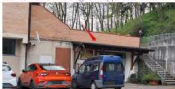
Figura 91: Esterno 7C Ingresso fronte Ovest, la freccia rossa indica la tettoia non legittimata
