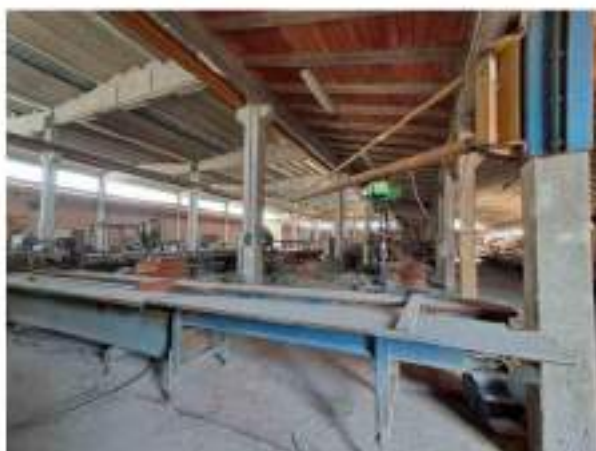
Figura 77: interno 3B - zona di congiungimento "barchessa" tra il capannone di primo impianto e le nuove realizzazioni
