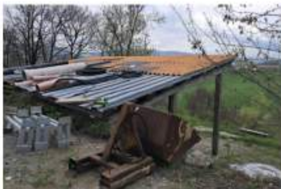
Figura 113: esterno 9D - tettoia irregolare Prospetto Sud Est ripresa ad altezza del piazzale
