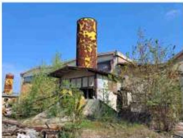
Figura 71: esterno 8 B - Prospetto Nord - Vista della zona di lavorazione del cemento
