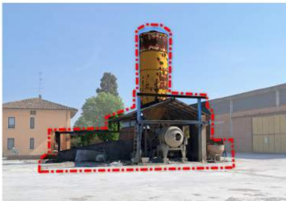
Figura 37: esempio di elementi oggetto di demolizioni e smaltimento, oltre ad altri elementi, cumuli e materiali vari
