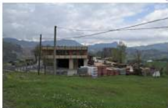
Figura 105: Esterno 1D - vista dalla strada prospetto Sud ed in distanza alberi presenti sulla Particella 479
