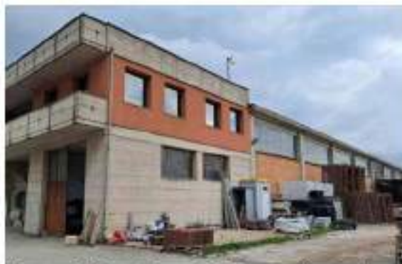
Figura 110: esterno 6D Prospetto Sud - Est
