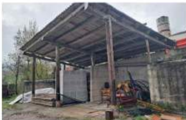
Figura 115: esterno 11 D tettoia irregolare Prospetto Nord Est ripresa ad altezza del campo
