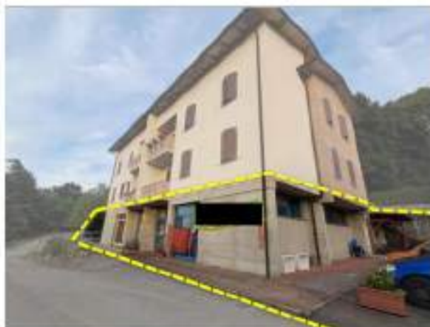
Figura 86: Esterno 2C - vista dall'area cortiliva - Ingresso Centro Diurno - Prospetti Nord ed Ovest
