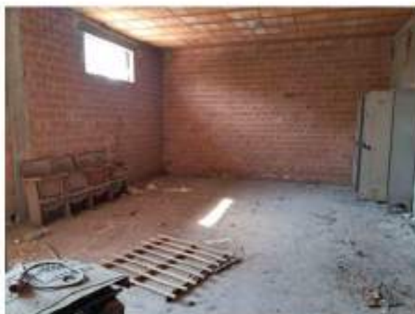
Figura 80: interno 6B nella parte nuova dei servizi accessori
