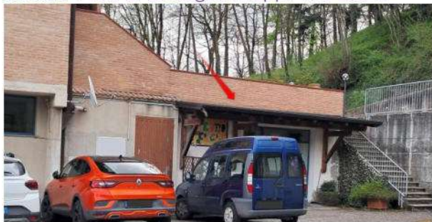
Figura 23: Esterno 7C Ingresso fronte Ovest, la freccia rossa indica la tettoia non legittimata
