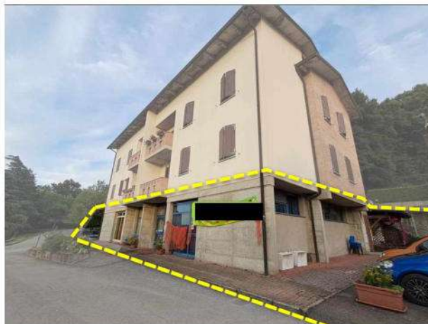
Figura 18: Esterno 2C - vista dall'area cortiliva - Ingresso Centro Diurno - Prospetti Nord ed Ovest
