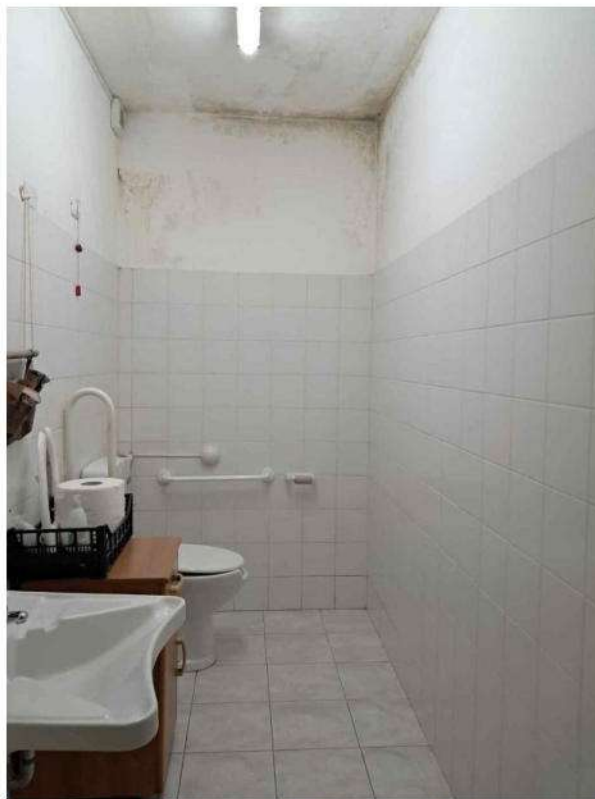
Figura 34: Interno 10 C - Secondo Bagno
