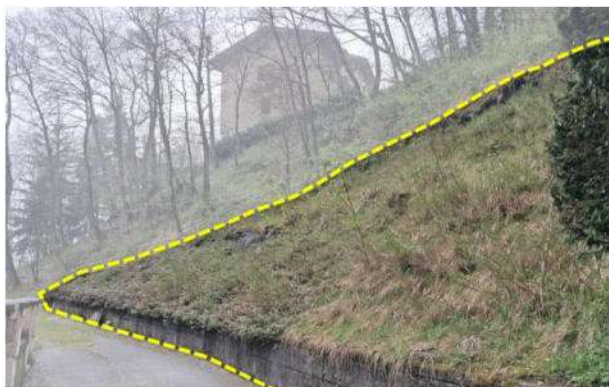
Figura 21: Esterno 5C - Area urbana, come si evince dalla foto presenta un'importante pendenza - prospetto Nord
