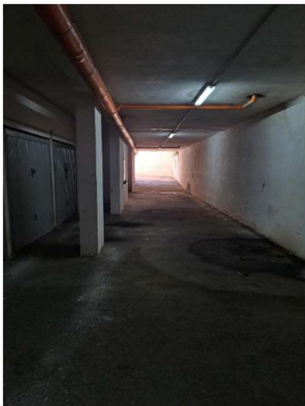
Vista interna del piano interrato
