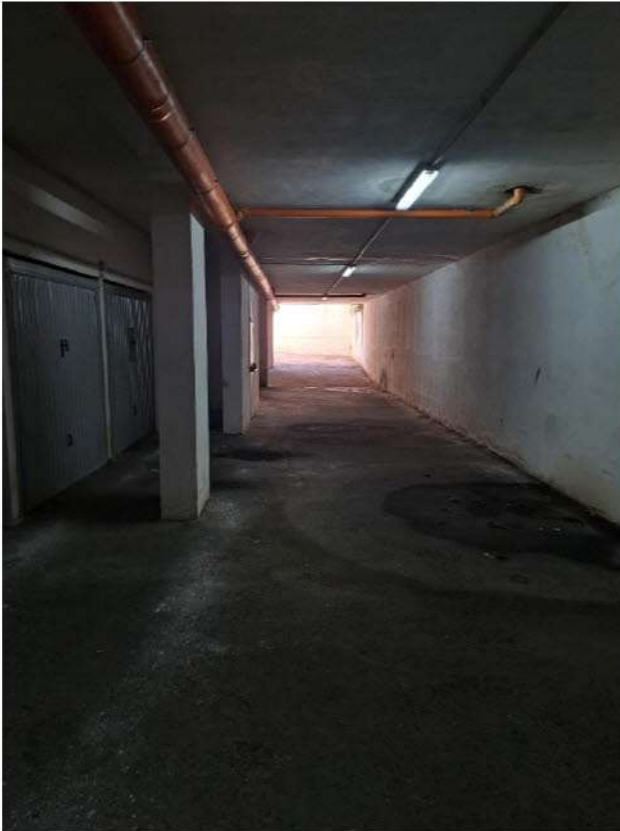
Vista interna del piano interrato
