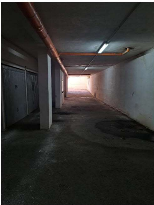
Vista interna del piano interrato
