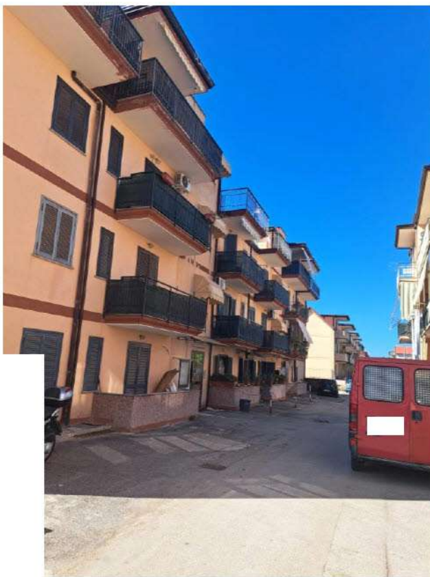
vista esterna del fabbricato ove sono allocati gli immobili de quo .
