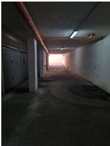
vista dell'area di manovra interna
