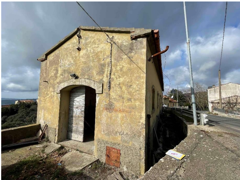
Foto n. 1 - Prospetto Sud del fabbricato
