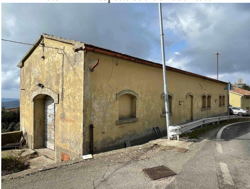
Foto n. 2 - Prospetti Sud ed Est del fabbricato
