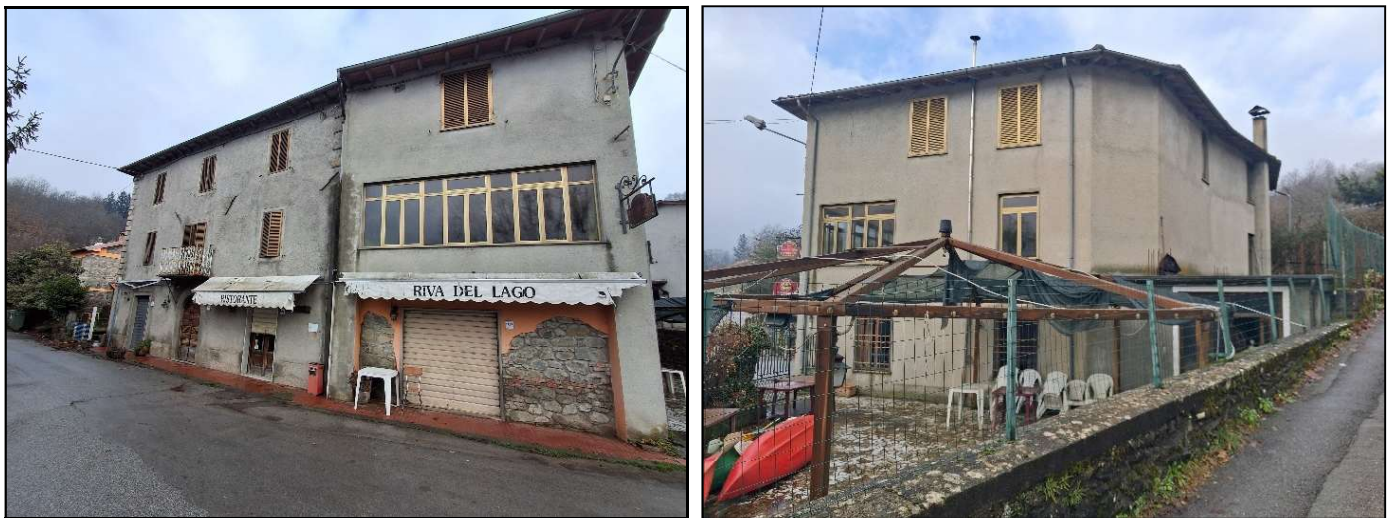
Viste esterne del fabbricato dalla Strada Comunale: prospetto principale e laterale con resede.
