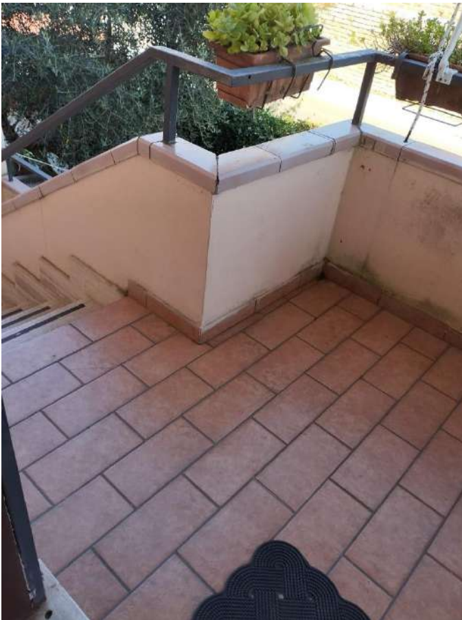
VISTA ESTERNA – INGRESSO PIANO PRIMO
