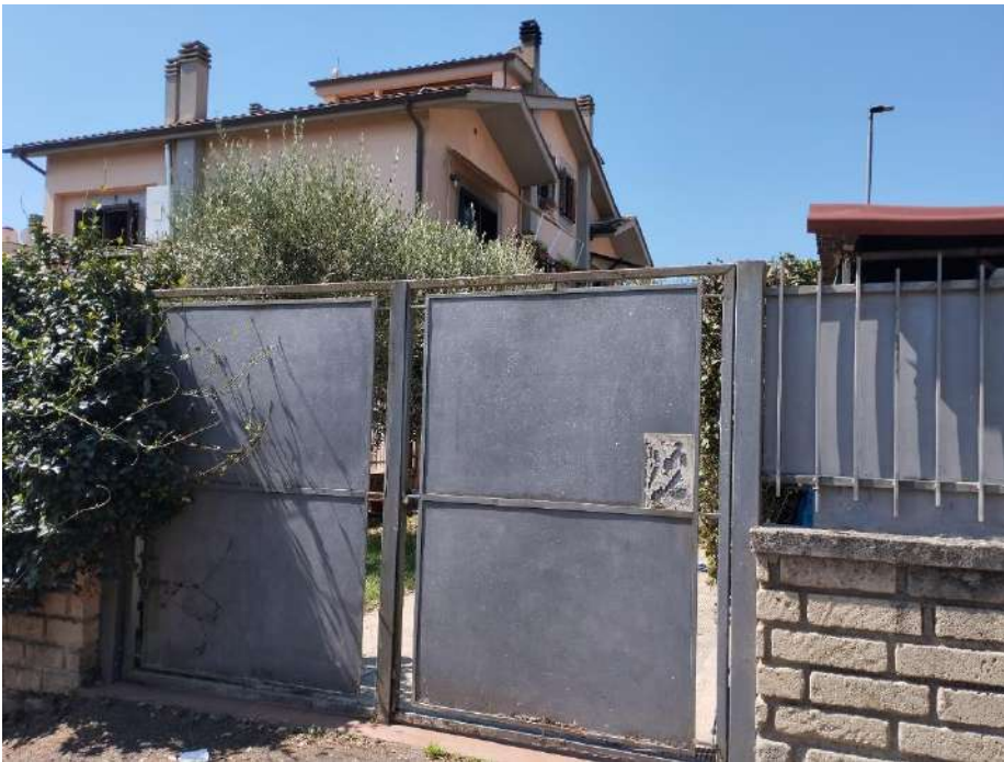
VISTA ESTERNA LATERALE
