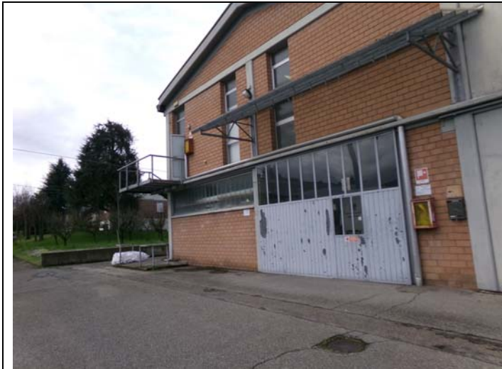
Magazzino a sud ex laboratorio
