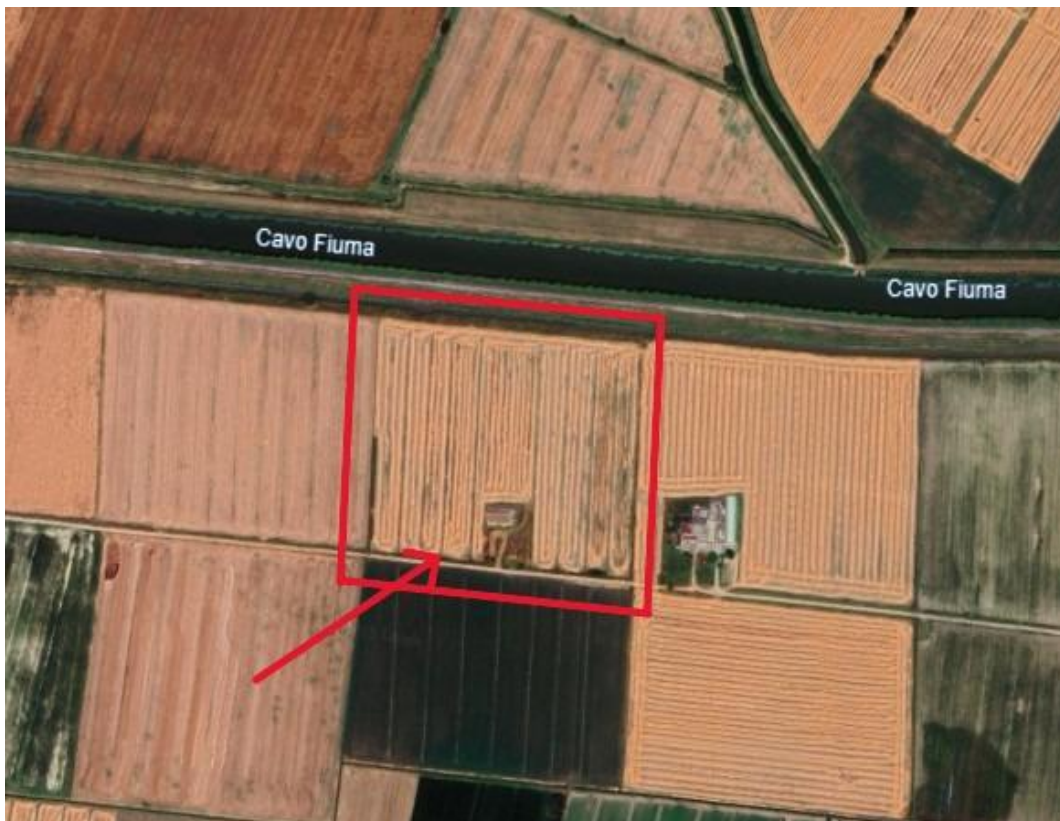
Figura 1 - INQUADRAMENTO DEL FABBRICATO NEL TERRITORIO
