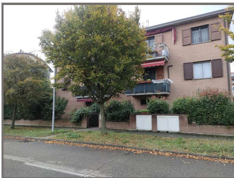
APPARTAMENTO CON BALCONE OGGETTO DELL'ACCERTAMENTO UBICATO AL SECONDO PIANO
