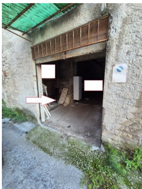
Figura 8 accesso al deposito dal largo Sanità snc in Capua
