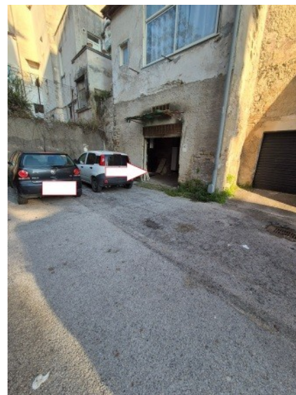
Figura 6 accesso all'immobile pignorato situato nel largo Sanità snc in Capua
