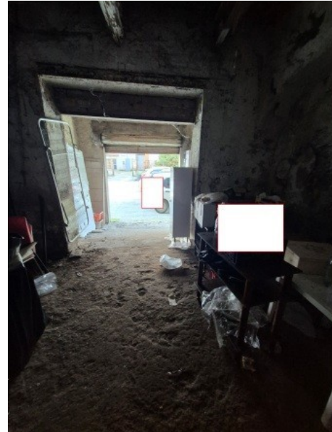
Figura 11 interno del deposito
