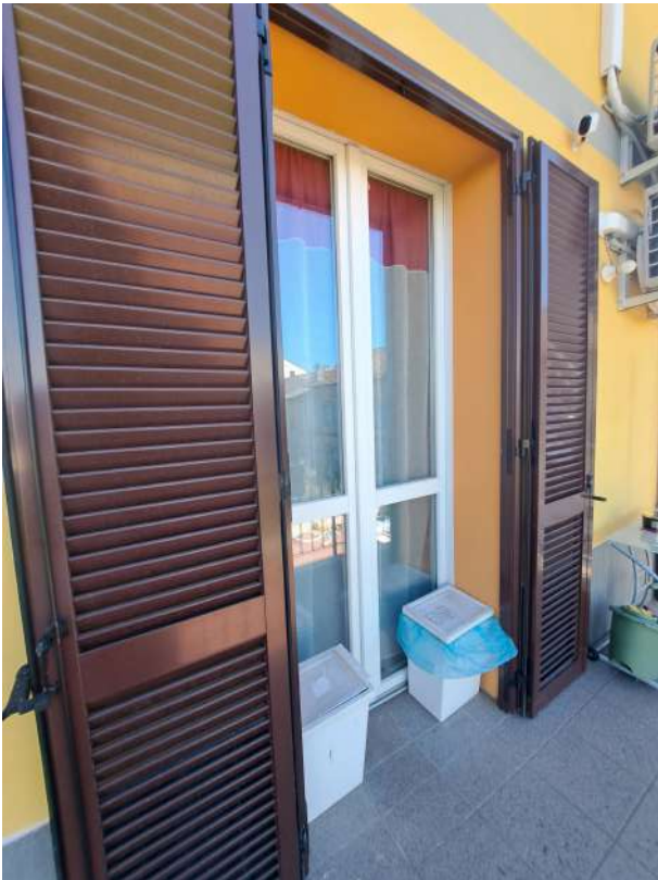
Figura 49- Portafinestra su ballatoio
