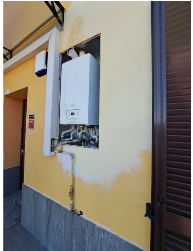
Figura 50- Caldaia esterna
