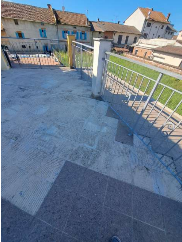
Figura 64- copertura del sub 4
