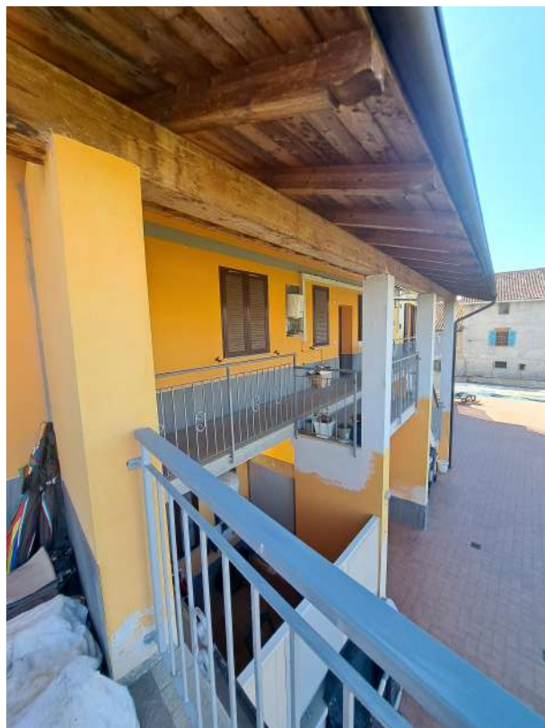
Figura 36- vista area ballatoio
