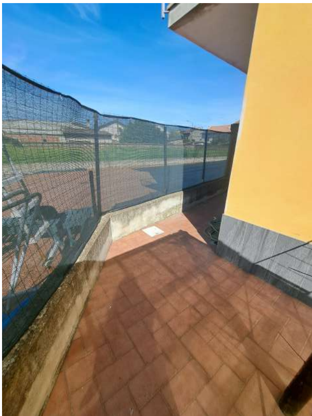
Figura 8- recinzione e pavimentazione esterna
