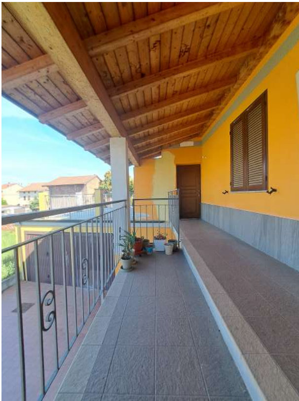
Figura 27- ingresso da ballatoio
