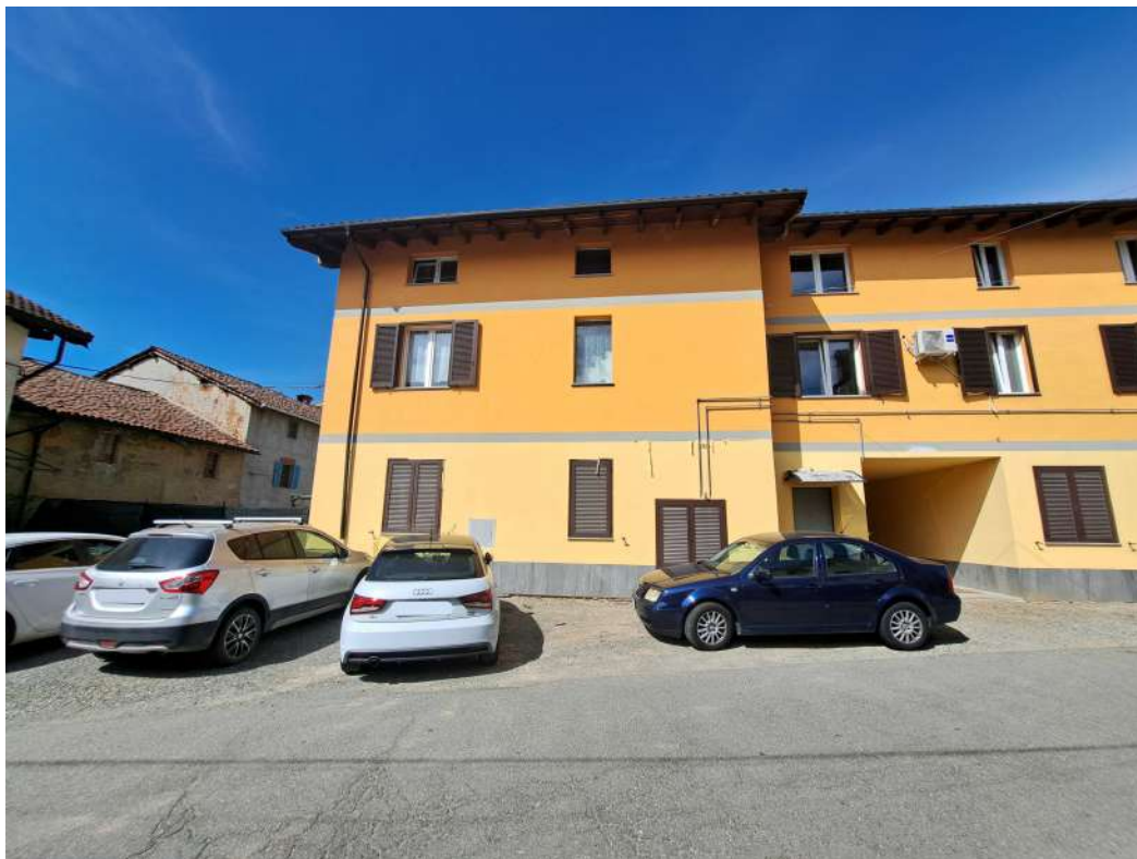
Figura 39- Prospetto da via Viazzi
