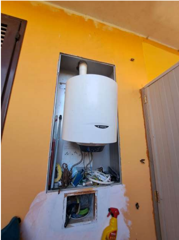
Figura 23- boiler esterno
