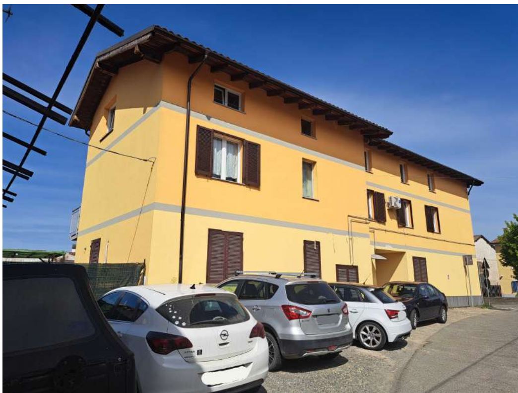
Figura 46- Prospetto da via Viazzi
