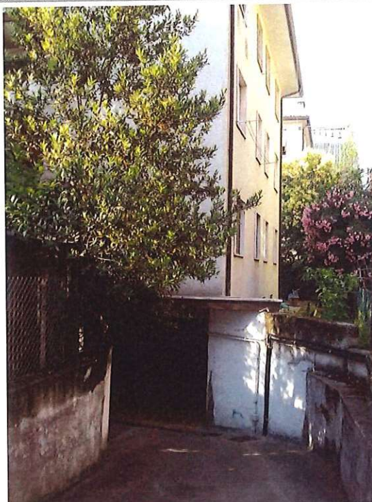
Foto n. 3 – vista ingresso rampa garage
