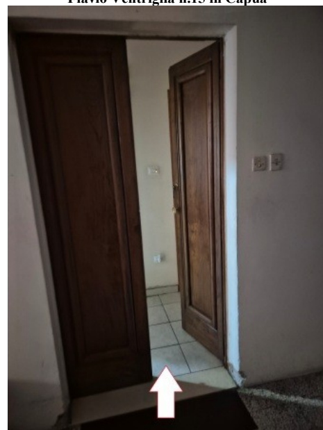
Figura 6 accesso all'appartamento al piano rialzato
