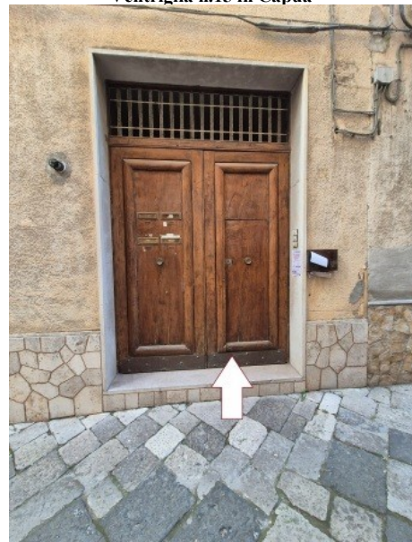
Figura 4 portone di accesso al vano scala comune dal vico Flavio Ventriglia n.15 in Capua
