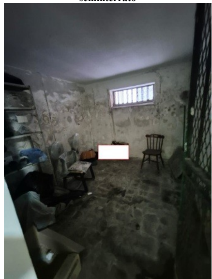
Figura 20 cantinola al piano seminterrato
