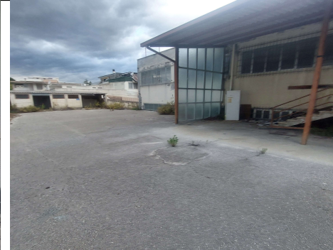
Baia di carico a SUD
