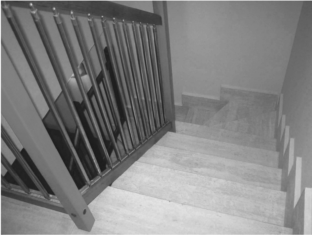
FOTO n. 11 - Panoramica interna del compendio pignorato
