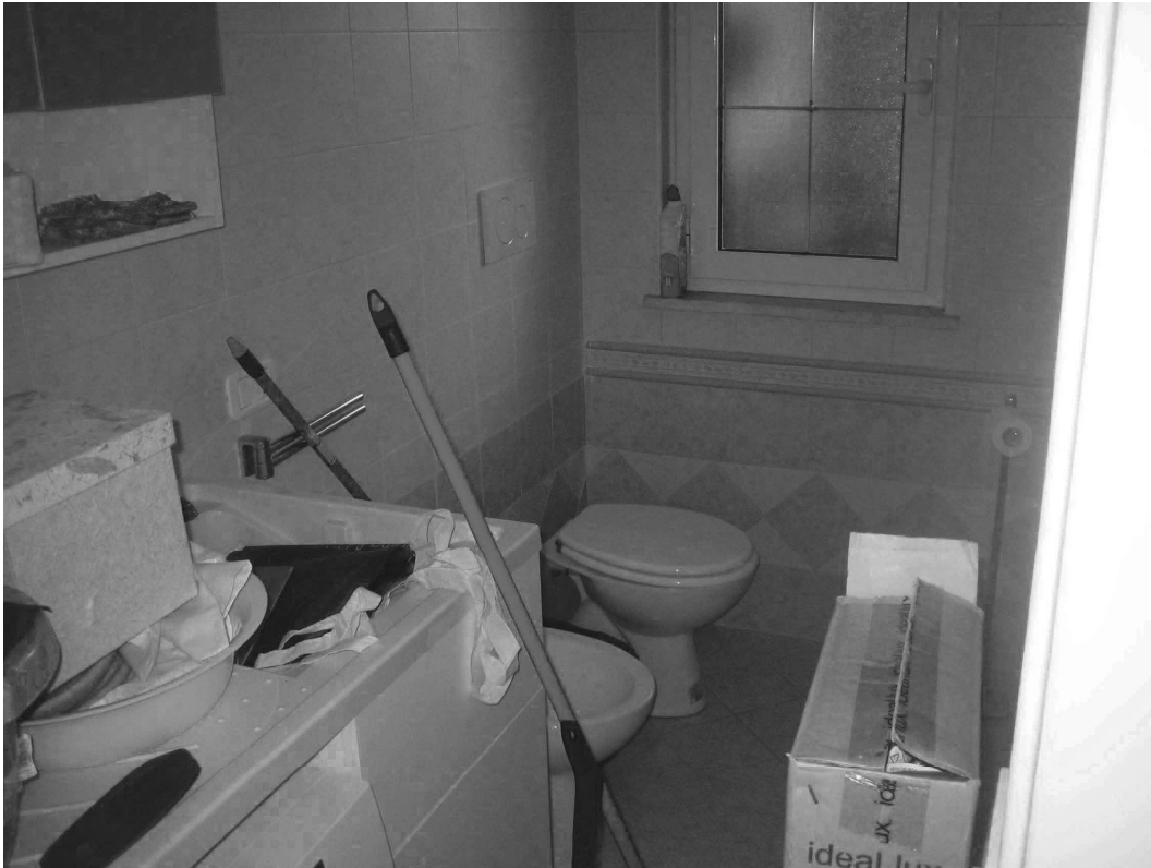
FOTO n. 9 - Panoramica interna del compendio pignorato
