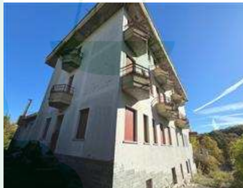
Foto - Prospetto nord-ovest
