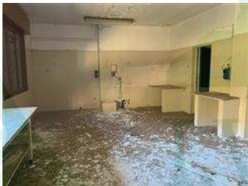
Foto - Piano terra
