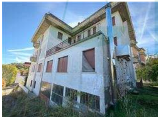
Foto - Prospetto est
