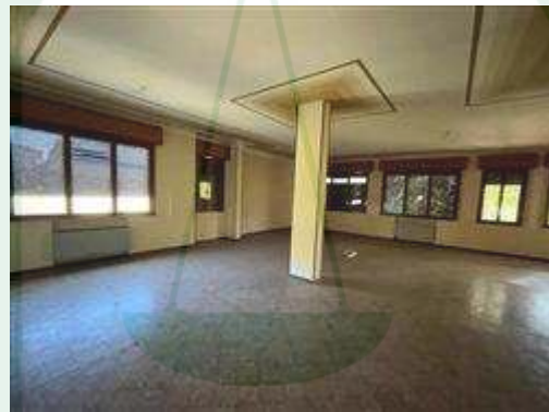
Foto - Piano terra
