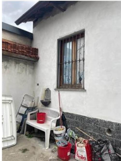
l'affaccio sul ballatoio comune
