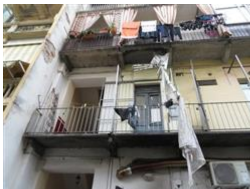
facciata lato cortile
