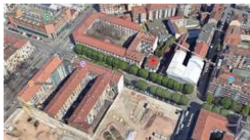
estratto di mappa 3D da Google Earth, la freccia di colore rosso indica qualitativamente la posizione del fabbricato in cui si trova l'immobile oggetto di pignoramento
