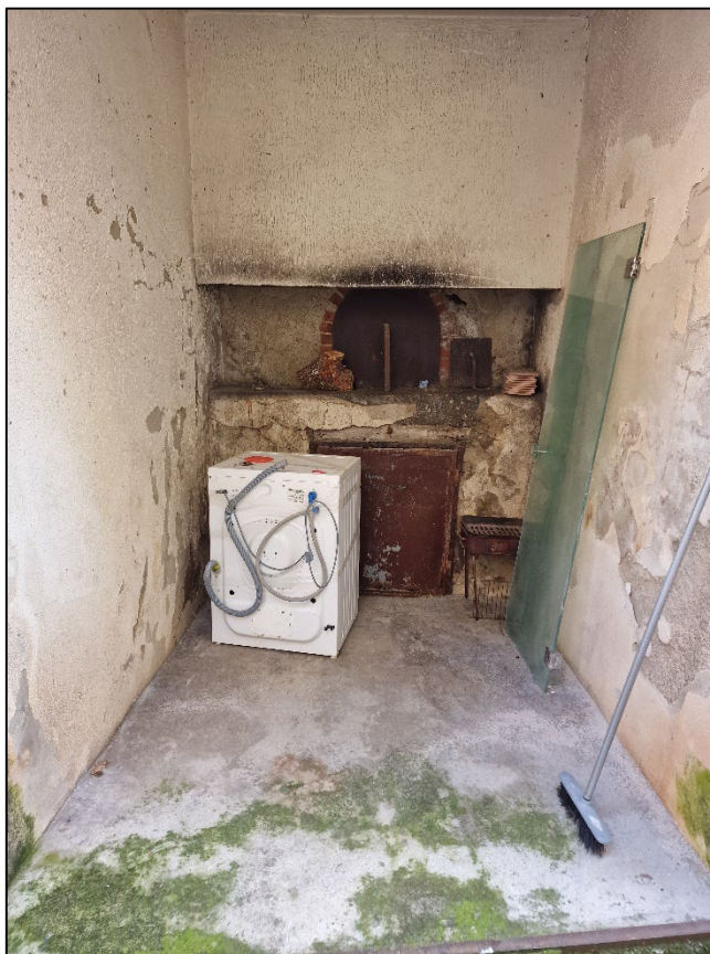
Foto 20: vista del forno ubicato all'esterno, di uso comune ed esplicitamente menzionato nell'Atto di Compravendita del 2012.
